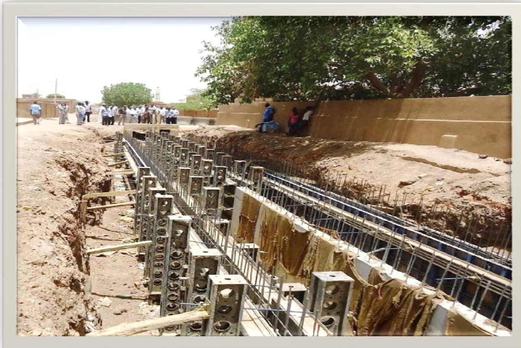
الشكل (4-6) نماذج لمصارف تحت التشييد.
