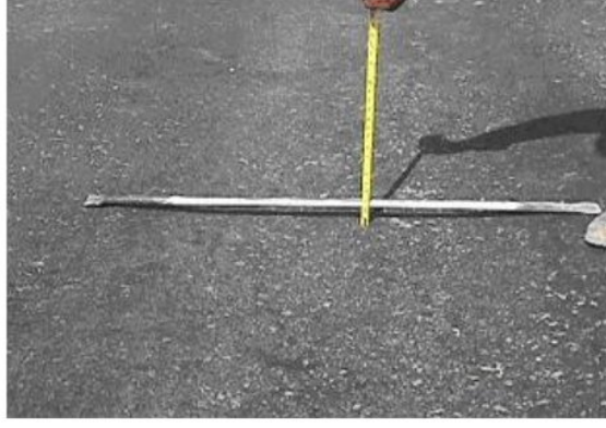
شكل رقم (2-28) يوضح شدة منخفضة للتخدد
