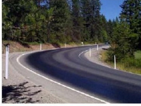
شكل رقم(2-31) يوضح شدة منخفضة لنزيف الأسفلت
