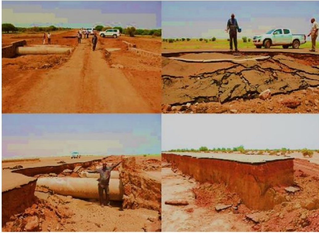
شكل رقم (3-1) يوضح صوره نماذج لأنواع الانهيارات التي حدثت للطريق
