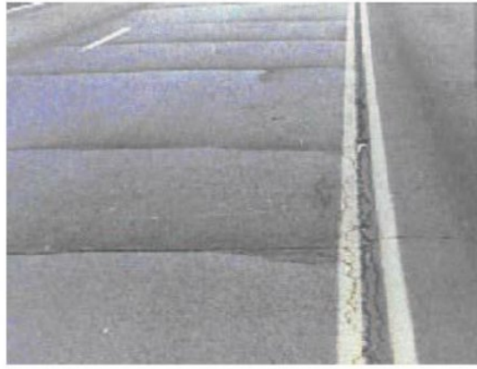
شكل رقم (2-14) يوضح شدة متوسطة للشقوق الانعكاسية
