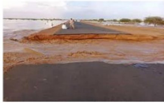
شكل رقم (3-6) يوضح صوره جرف الطريق
