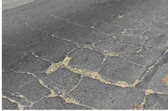
شكل رقم(2-6) يوضح شدة عالية للشقوق الشبكية
