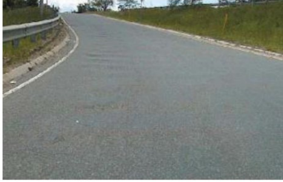
شكل رقم (2-43) يوضح شدة عالية للتموجات
