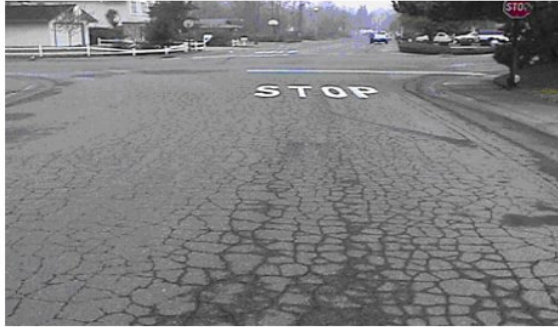
شكل رقم (2-3) يوضح شدة عالية للشقوق التماسحية
