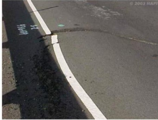
شكل رقم (2-15) يوضح الشقوق الانزلاقية
