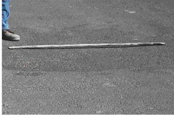
شكل رقم(2-23) يوضح شدة متوسطة للهبوطات
