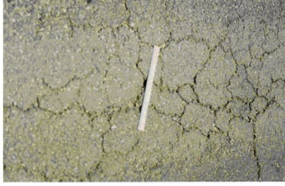
شكل رقم (2-2) يوضح شدة متوسطة للشقوق التماسحية
