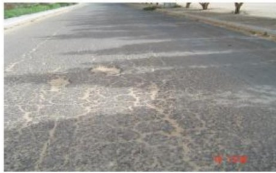
شكل رقم (2-36) يوضح شدة عالية لتطاير الأسفلت
