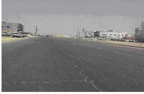
شكل رقم (2-8) يوضح شدة متوسطة للشقوق الطويلة والعريضة
