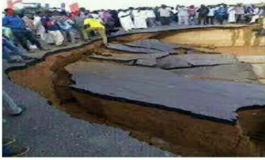
شكل رقم (3-6) يوضح صوره جرف الطريق
