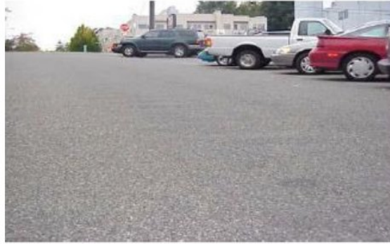
شكل رقم (2-41) يوضح شدة منخفضة للتموجات
