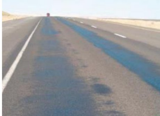
شكل رقم(2-32) يوضح شدة متوسطة لنزيف الأسفلت
