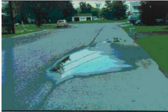
شكل رقم(2-24) يوضح شدة عالية للهبوطات
