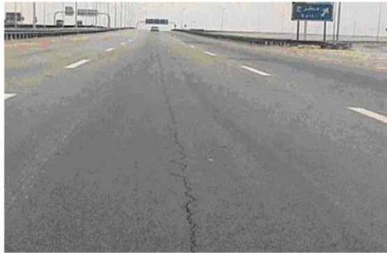
شكل رقم(2-7) يوضح شدة منخفضة للشقوق الطويلة والعريضة
