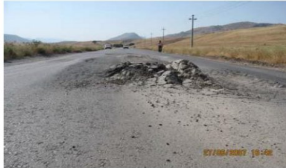
شكل رقم(2-45) يوضح الانتفاخ
