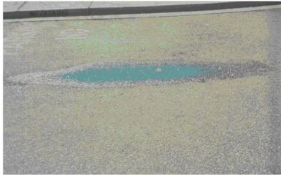
شكل رقم (2-22) يوضح شدة منخفضة للهبوطات
