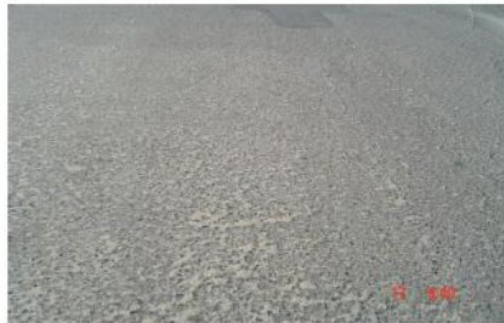
شكل رقم(2-35) يوضح شدة متوسطة لتطاير الأسفلت
