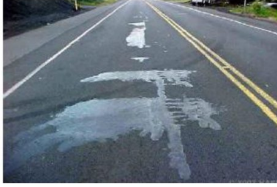
شكل رقم(2-33) يوضح شدة عالية لنزيف الأسفلت
