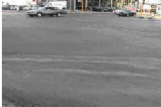
شكل رقم (2-38) يوضح شدة منخفضة للتحديدات
