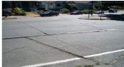
شكل رقم (2-13) يوضح شدة منخفضة للشقوق الانعكاسية
