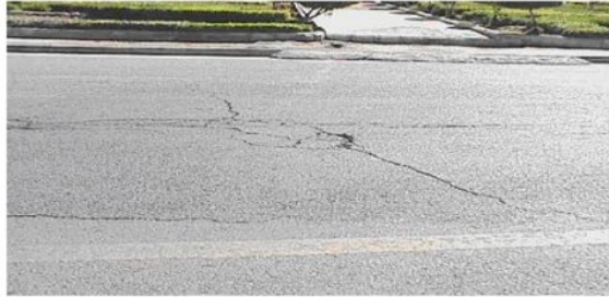
شكل رقم (2-9) يوضح شدة متوسطة للشقوق الطويلة والعريضة
