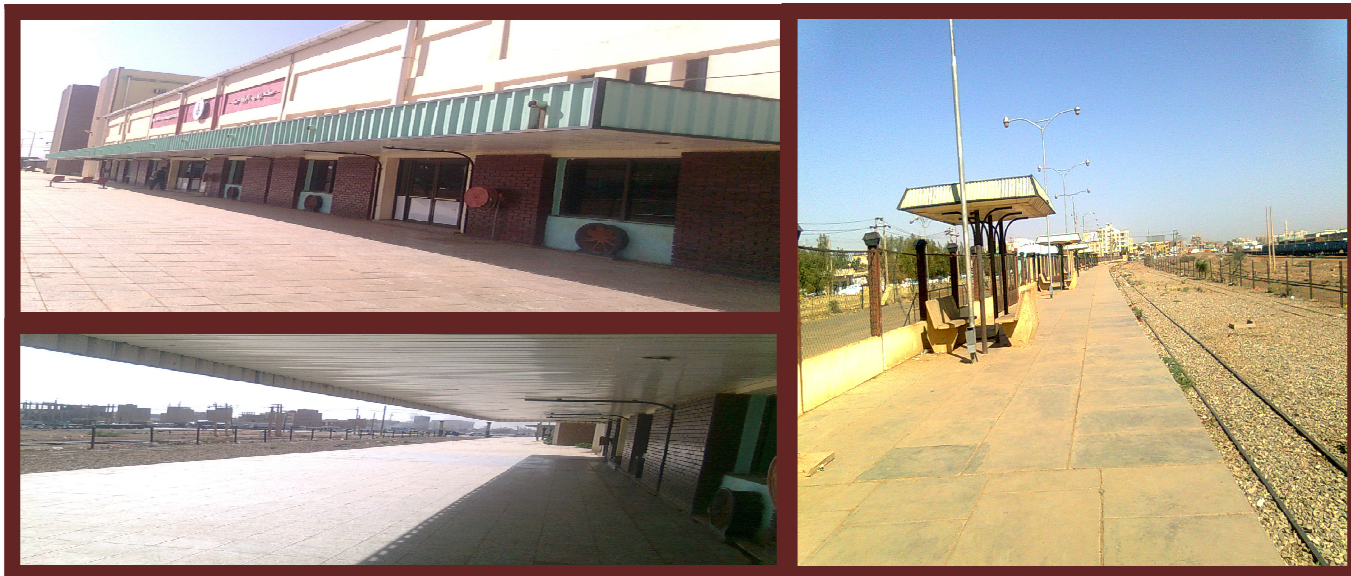
صورة رقم (2-16) توضح رصيف محطة بحري وعناصره
