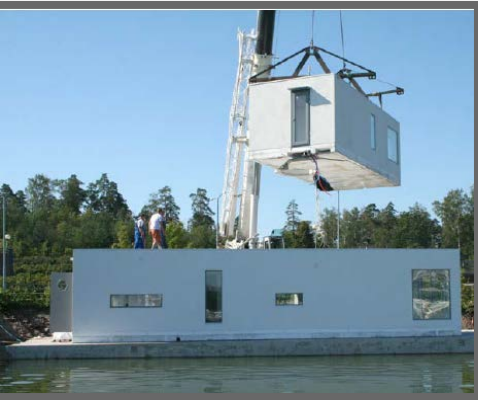
توضح طريقة تركيب المبنى مسبق التجهيز صورة (٧-٧)
