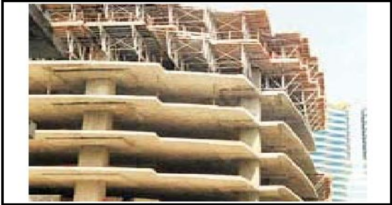
الشكل رقم (4.2) يبين البلاطة المسطحة (مرجع رقم 8)
