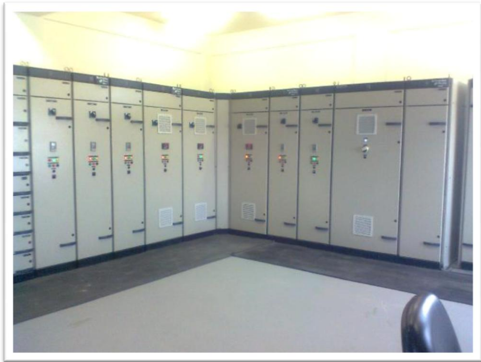
شكل رقم (15) يوضح غرفة التحكم من الداخل
