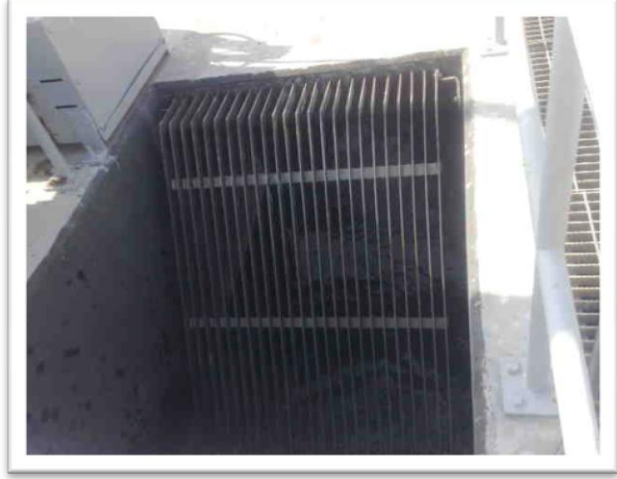
شكل رقم (1) يوضح مصافي حجز الرمال
