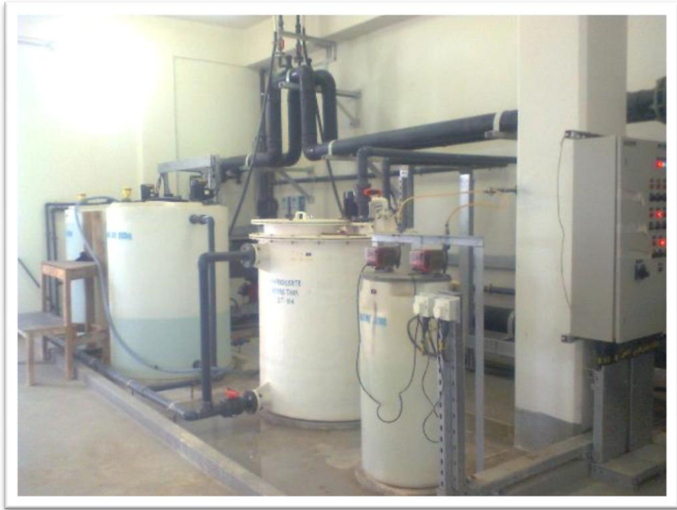
شكل رقم (12) يوضح المضخات التي تضخ المياه المعالجة لشبكة الري الرئيسية
