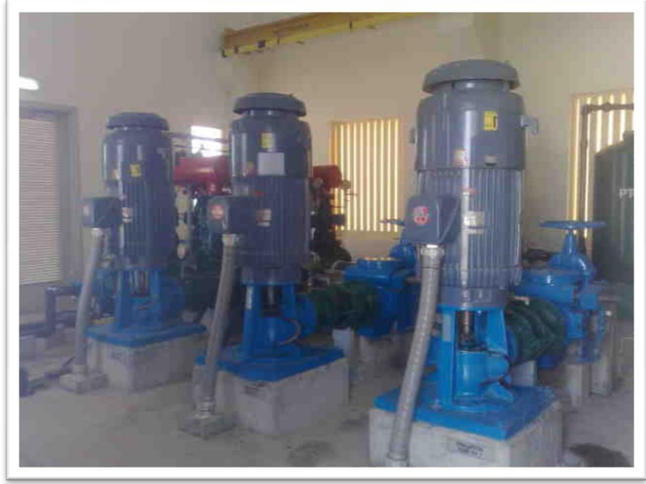
شكل رقم (13) يوضح المضخات التي تضخ مياه الشوائب والمخلفات إلى حوض تكثيف الحمأة
