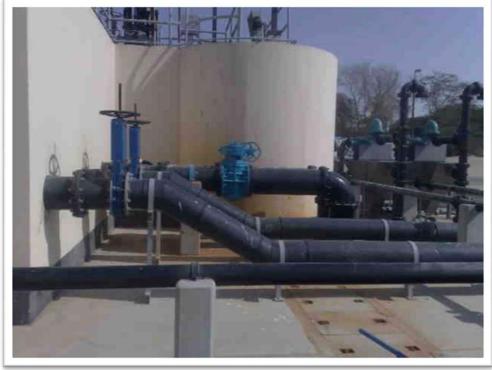
شكل رقم (4) يوضح أنابيب التغذية الرئيسية
