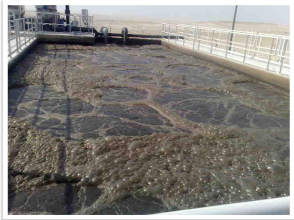
شكل رقم (8) يوضح حوض التهوية
