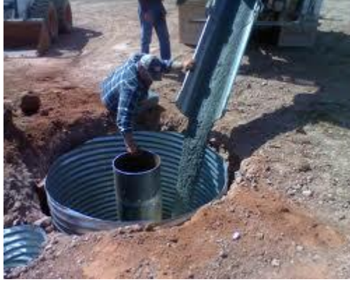
شكل (2-8) : أنبوب التوجيه (conductor pipe)
