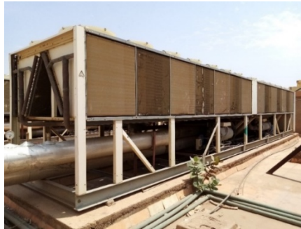
صورة 3-4 يوضح وحدة تصفية الماء بمستشفى رويال كير-المصدر: تصوير الباحثة
