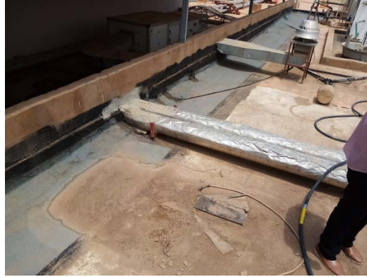
شكل 3-8 يوضح المواد العازلة المستخدمة لعزل المواسير ومجاري الهواء في مستشفى رويال كير-المصدر:تصوير الباحثة
