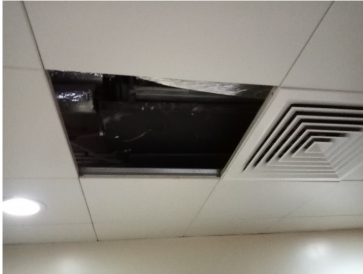
صورة 3-13 يوضح مخارج الهواء في غرف المرضى في مستشفى رويال كير.-المصدر: الباحثة
