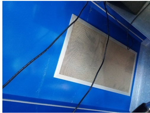
صورة3-11 يوضح مخارج ومدخل الهواء بغرفة العمليات في مستشفى رويال كيرالمصدر:الباحثة.
