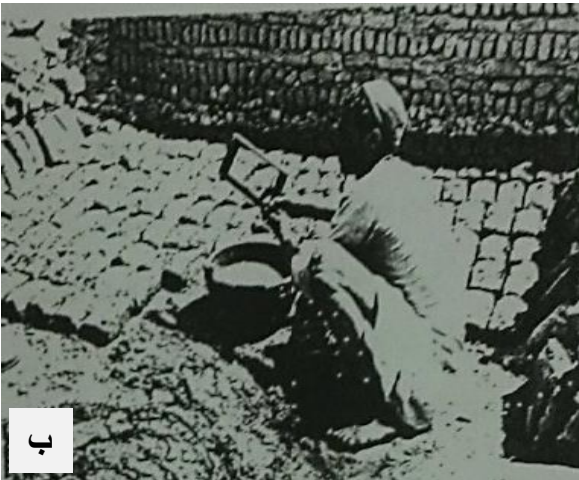
شكل (3-36) يوضح تقنيات صناعة وبناء بالطوب اللبن وسمك الحوائط الكبير التي تميز بها المسكن النوبي (المصدر: احمد محمود عارف-2003)
