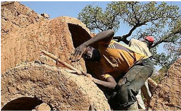
شكل(4-7): استخدام الطوب اللبن في عمليات البناء للمساكن(المصدر: الباحث)
