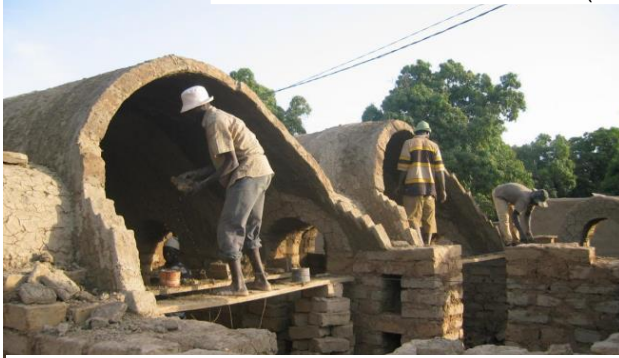
شكل(3-42): تقنيات بناء القبوات بالطوب اللبن التي تميز بها النوبيين (المصدر: elaalnoba.blogspot.com )
