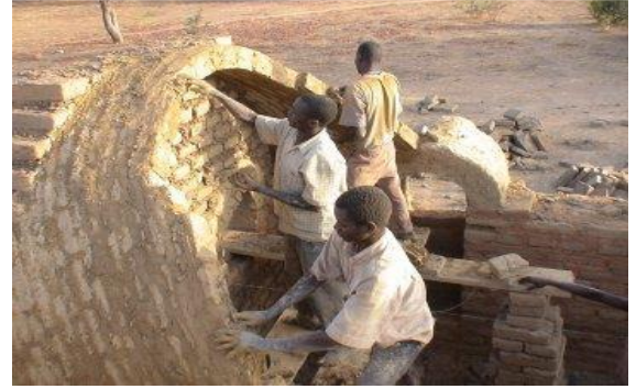
شكل(3-42): تقنيات بناء القبوات بالطوب اللبن التي تميز بها النوبيين (المصدر: elaalnoba.blogspot.com )
