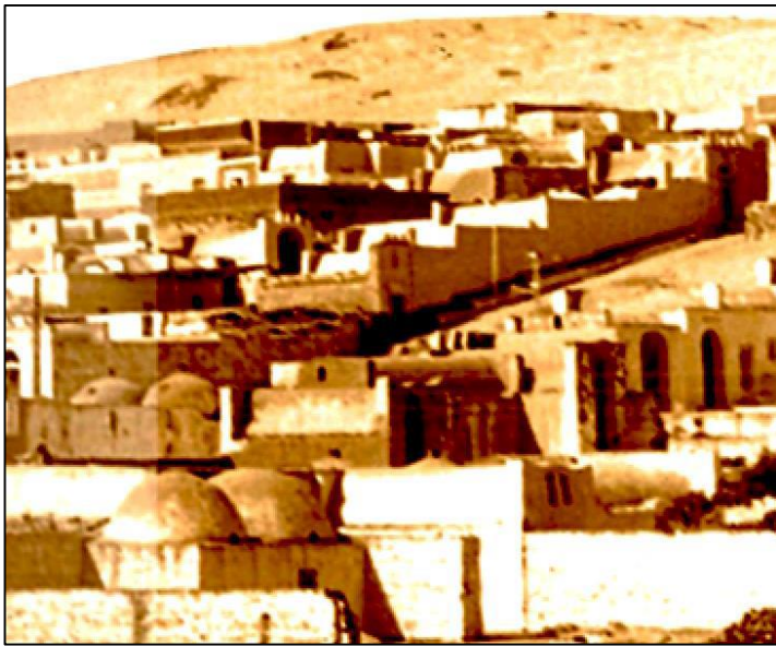
شكل(3-8) :التوزيع المتدرج للمساكن تماشيا مع انحدار الأرض في إحدى القرى غرب أسوان (المصدر دينا علاء، 2013)
