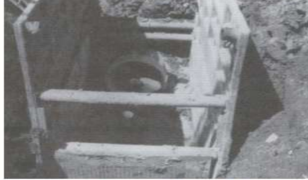
٣- اختبار المواسير ثم ردم الخندق
