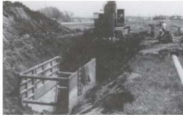
١- حفر الخندق وعمل الشدات
