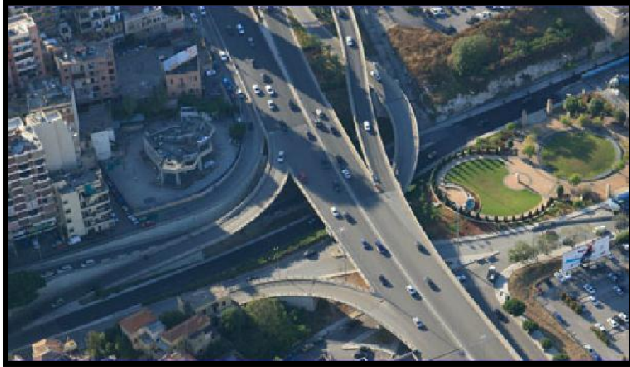
الصورة(13:4): جزء من شبكة الطرق بمنطقة وسط بيروت
