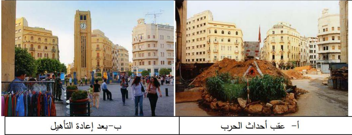
الصورة (10:4) : ساحة النجمة ، قلب المركز التقليدي لبيروت
