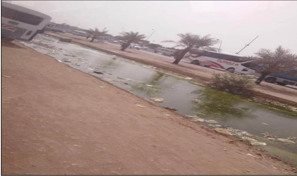
الشكل رقم (3-6) التلوث الصحي والبيئي الناتج عن طفح شبكة الصرف الصحي- المصدر (الباحث)
