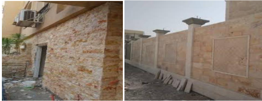
صورة رقم 14. 1 توضح تغليف الواجهات بالبلاط فى الخرطوم المصدر : الباحث 2022م
