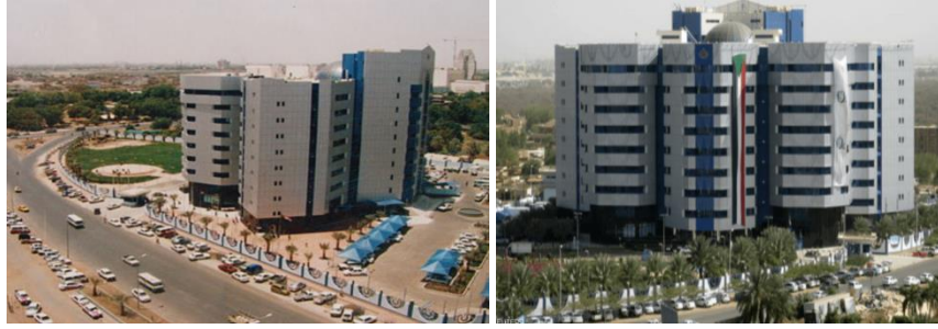
صورة رقم 13. 1 توضح استخدام واجهات الالمونيوم فى الخرطوم المصدر : الباحث 2022م
