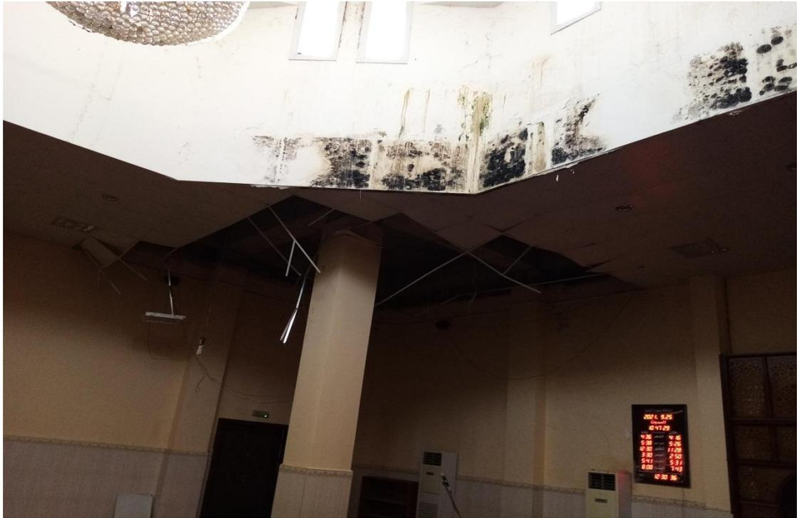
شكل رقم (٣-٣٥) يوضح إنهيار السقف المستعار ونمو العفن عليه
