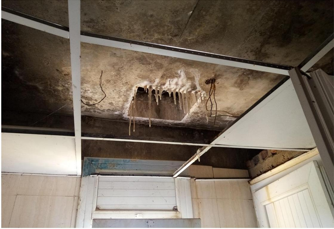
شكل رقم (٣-٣٦) يوضح الترسبات الملحية علي السقف الخرساني
