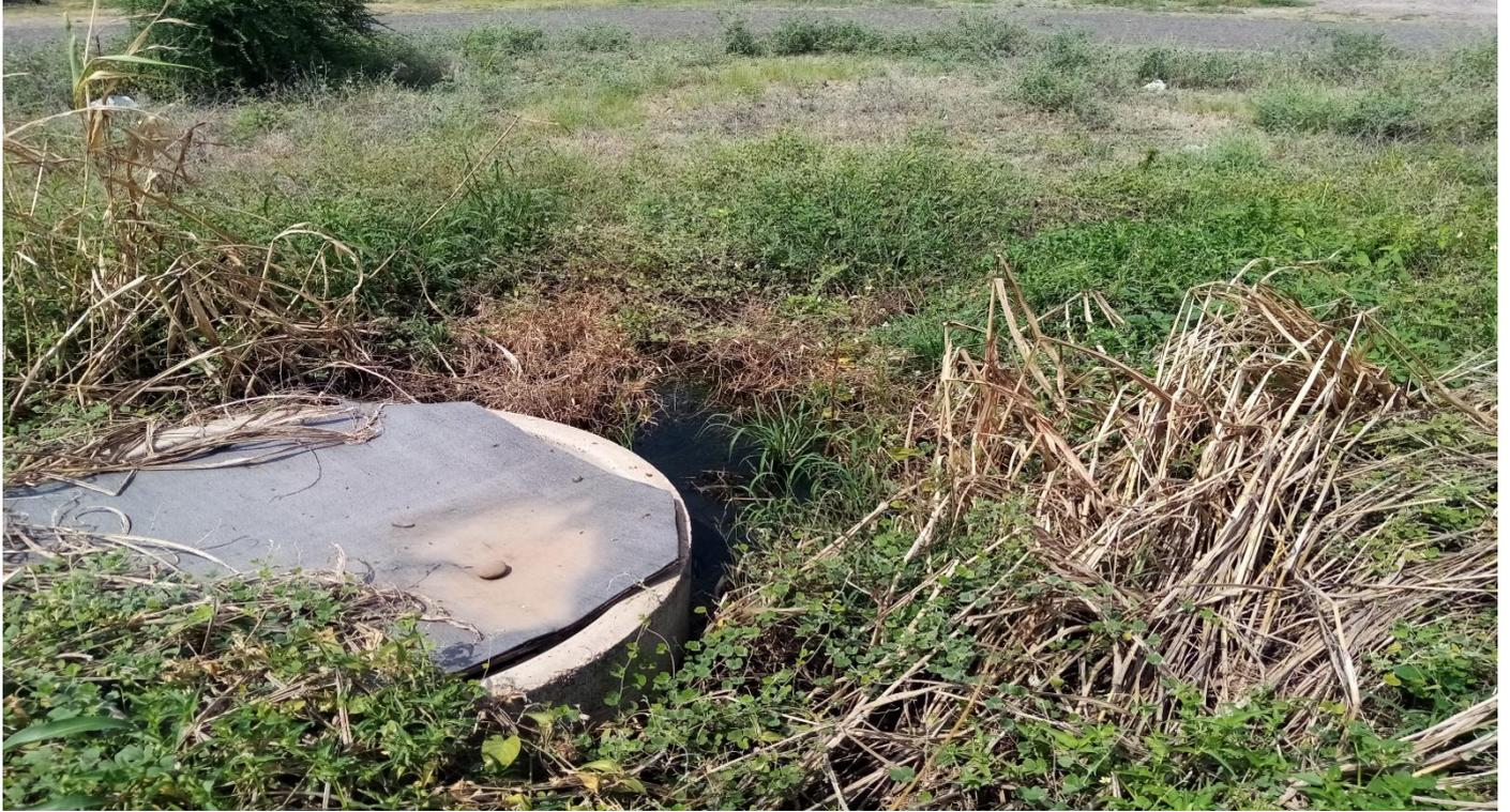
شكل رقم (٣- ١٩) تسرب مياه الصرف من المصاص ونمو النباتات حول حوض التحليل
