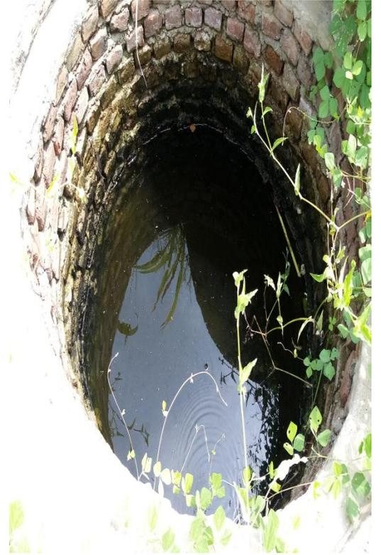
شكل رقم (٣-١٧) امتلاء حوض التحليل بالمياه وانتشار النباتات حوله بكثافة نتيجة لتسرب المياه من المصاص
