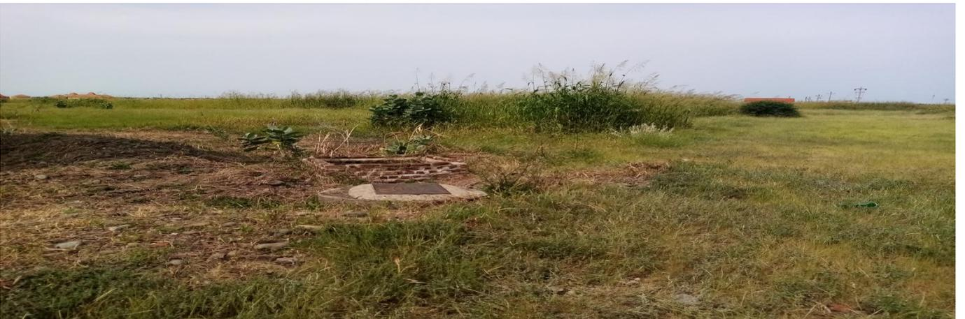
شكل رقم (٣-٢٦) يوضح نمو النباتات بغزارة حول حوض التحليل نتيجة للمياه المتسربة
