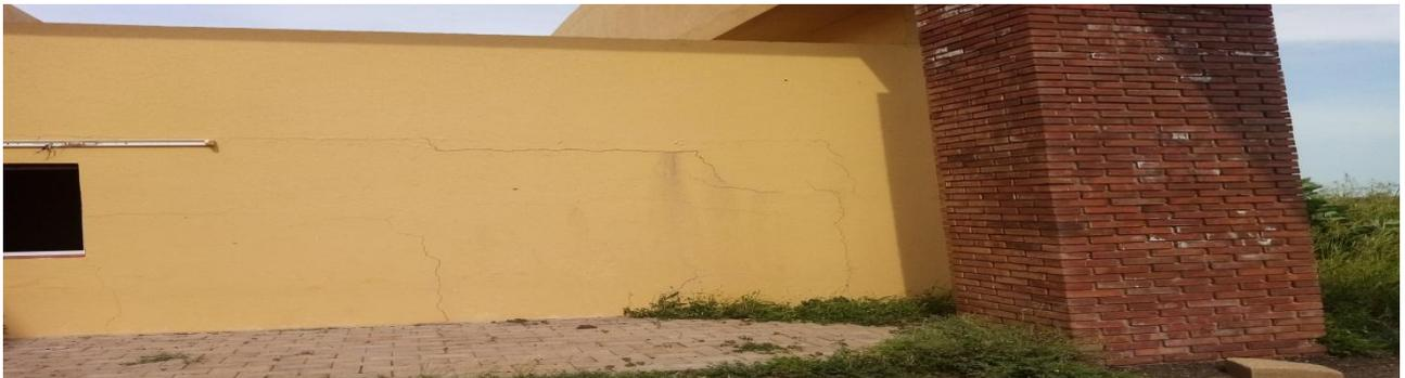
شكل رقم (٣- ٣٣) يوضح تشقق النقاشة و الحوائط الخارجية للمباني
