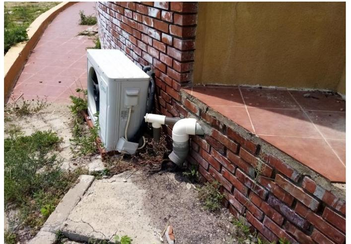
شكل رقم (٣-٣٢) يوضح نظام الصرف المنفصل عن الصرف الصحي
