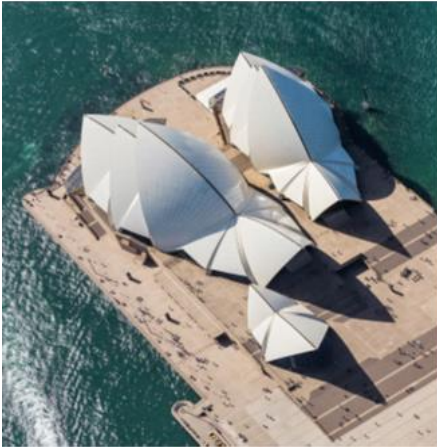
الصورة (1-4) توضح المنظور الخارجي لأوبرا سيدني
