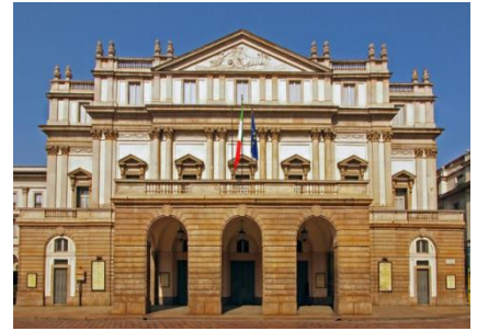
الصورة (10-3) توضح الواجهة الرئيسية
