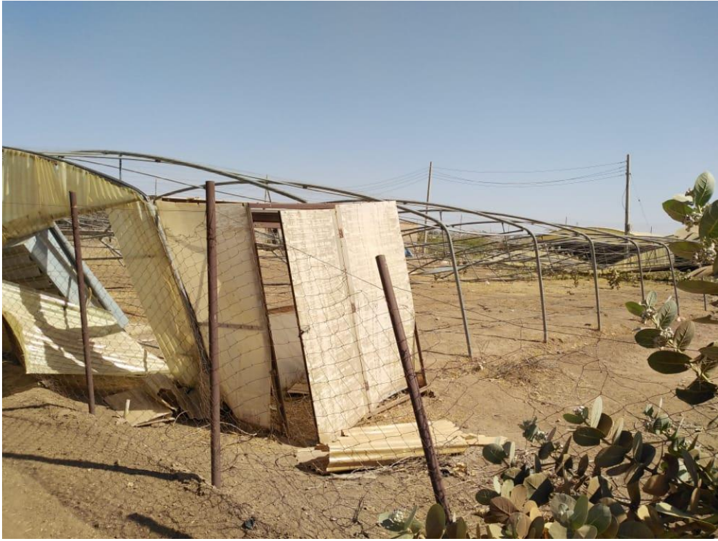
صورة رقم (3-6) بيت محمي مشمعه ممزق وهيكله مائل
