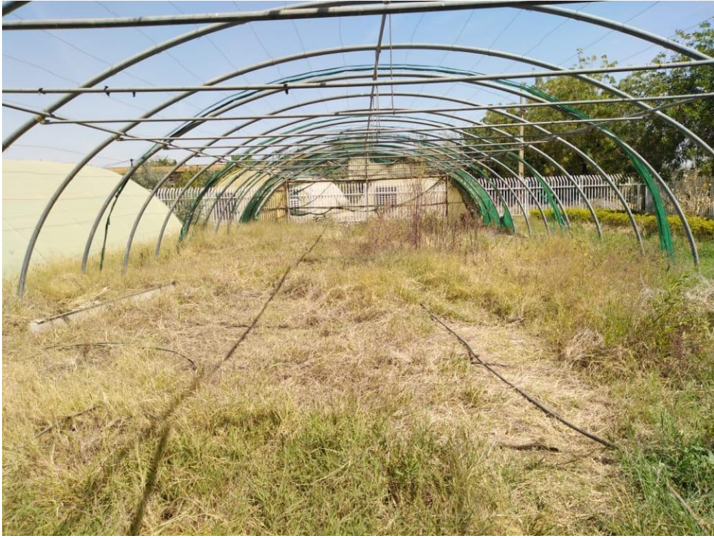
صورة رقم (3-4) صورة لبيت محمي مشمعه ممزق وهيكله بحالة جيدة
