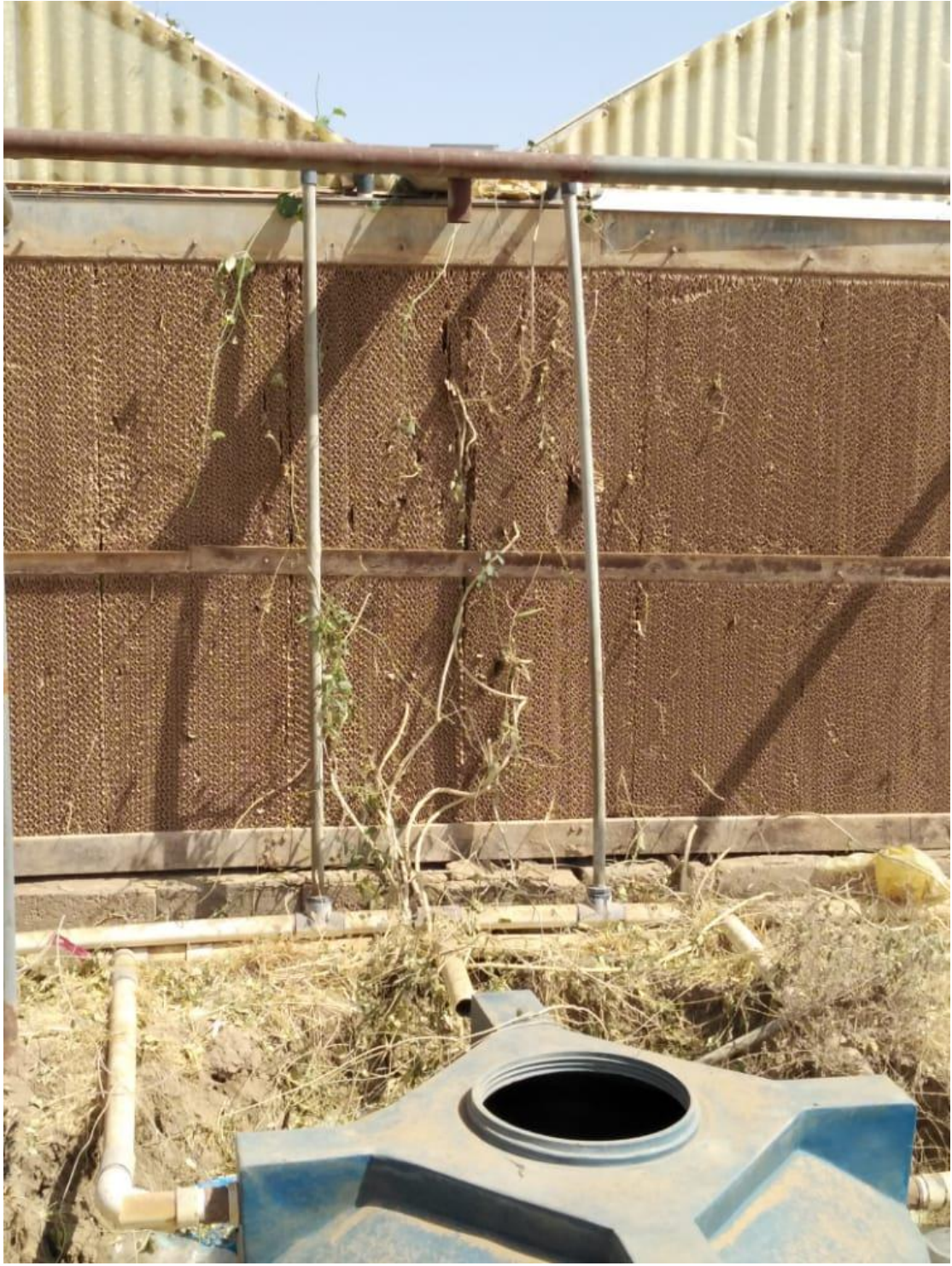
صورة رقم(3-10) مجمع بيوت وسائده بحالة متدهورة
