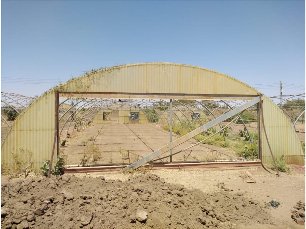
صورة رقم (9-3) بيت ممزق المشمع والوسائد وليس به مراوح
