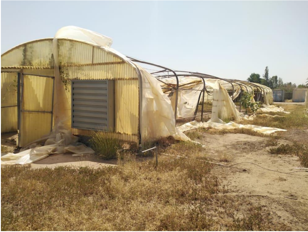
صورة رقم (2_3) توضيح بيت محمي مشمعه تالف
