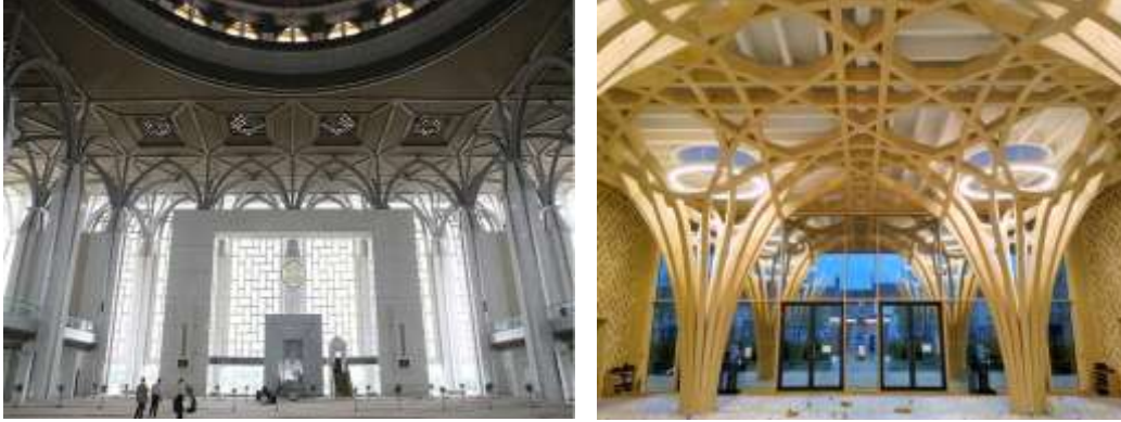
صورة رقم(39)عقود متشابكة مدمجة مع إضاءة صورة رقم(40) توضح تصميم آخر للعقود المتشابكة
