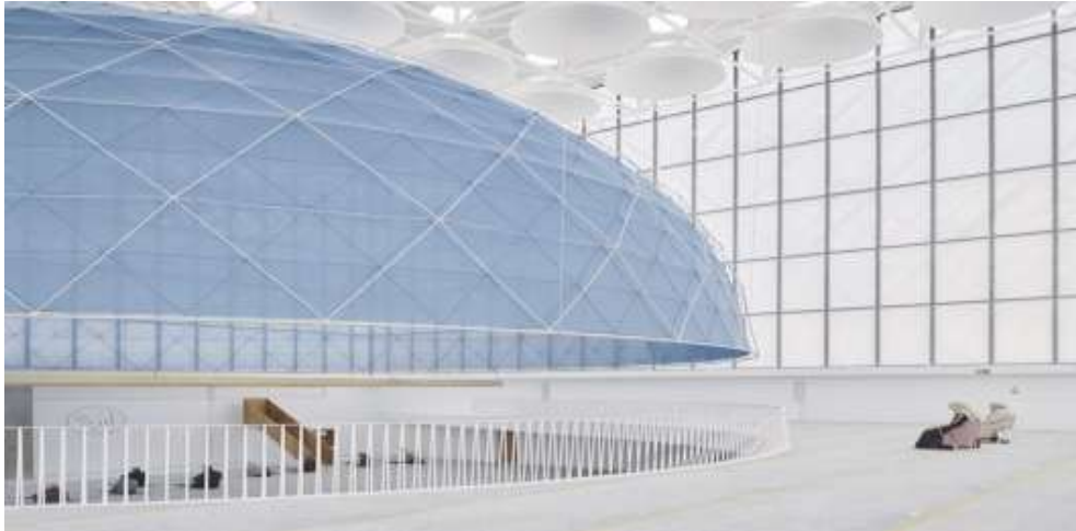
صورة رقم (79) توضح تفاصيل القبة الداخلية و المنبر
