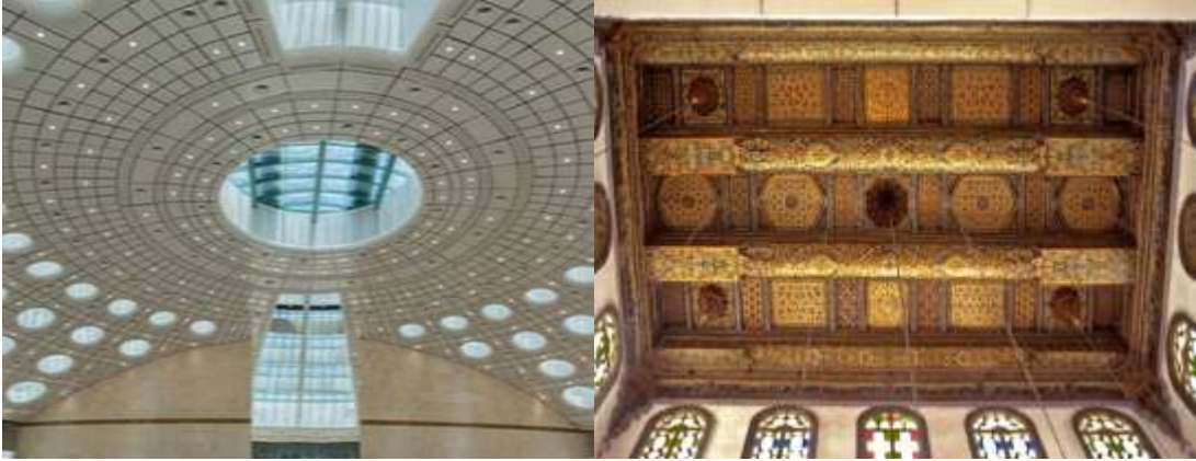
صورة رقم (22)سقف خشبي قديم بزخارف هندسية صورة رقم (23) سقف حديث من الجاج و الألمنيوم
