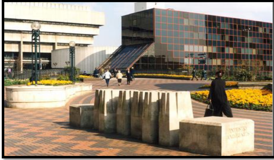
صورة (37) تناسق الكتل الجمالية الحجرية مع كتلة البناء الزجاجي في الخلف، وجزء من البناء الحجري الذي يظهر بالجانب الأيسر من الصورة، مما أعطى إيقاعاً مميزاً للحيز الحضري. المصدر مرجع رقم (42)
