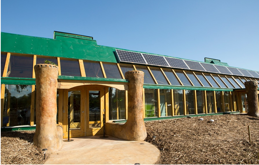
صورة (3-10) توضح استخدام ألواح الطاقة الشمسية للحصول على الطاقة للمبنى.
