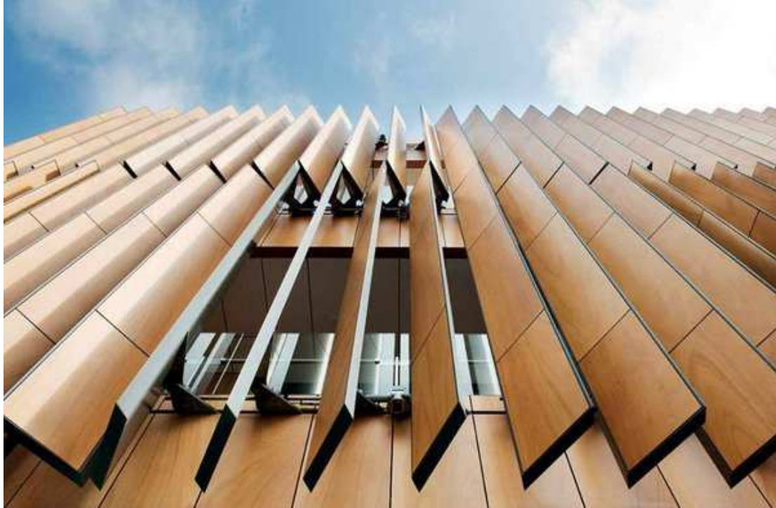
صورة (2-20) توضح مثال آخر لاستخدام كاسرات الشمس الراسية التي تتحرك مع زوايا الشمس في الواجهة الغربية./ المصدر (المغربي، 2005).
