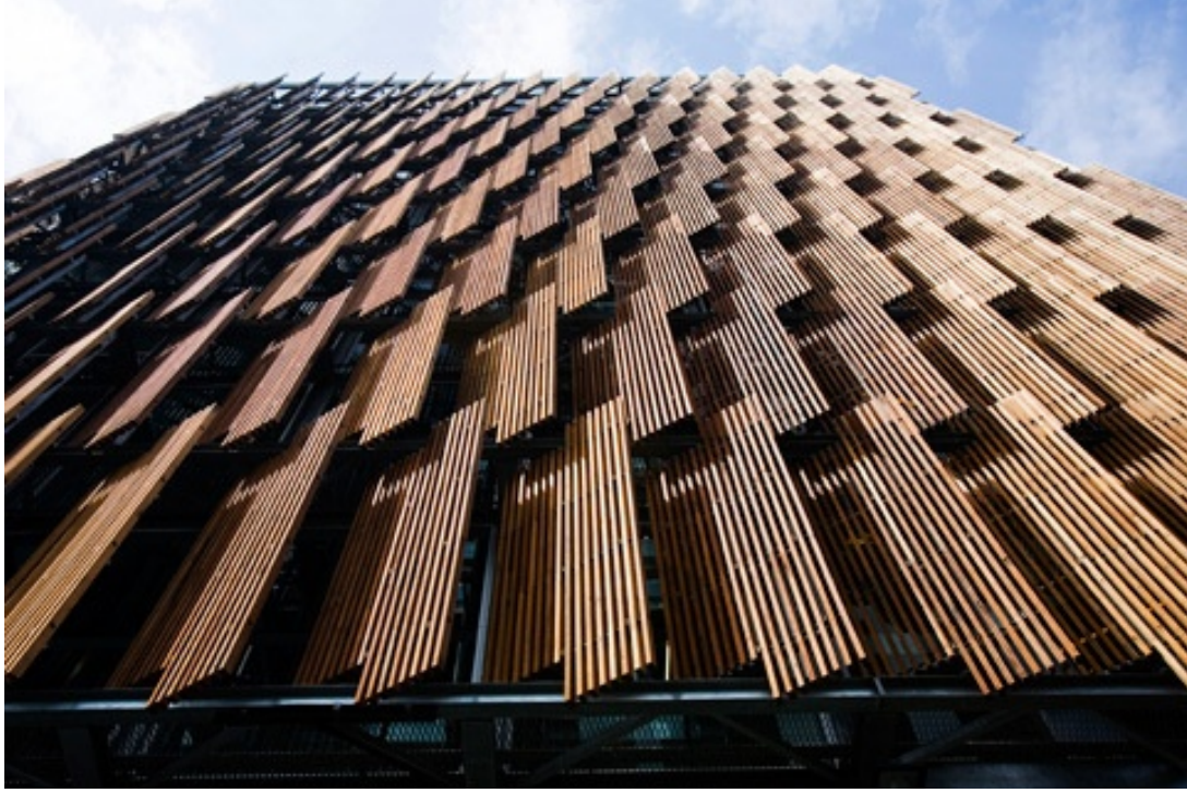
صورة رقم (2-19) توضح استخدام كاسرات الشمس الراسية التي تتحرك مع زوايا الشمس في الواجهة الغربية./ المصدر (المغربي، 2005).
