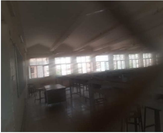
صورة (2-13) توضح السقف من الداخل
