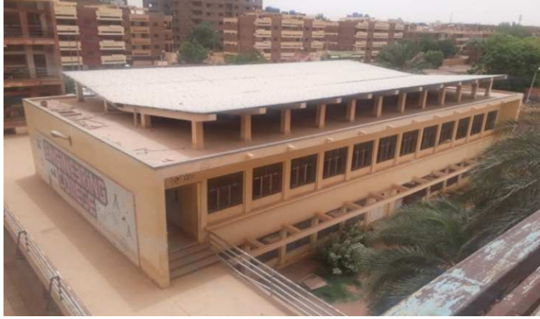
صورة (2-11) توضح استخدام سقف على طبقتين بجامعة السودان للعلوم والتكنولوجيا، حيث أن السقف الأساسي (ribbed slab) والسقف العلوي ألواح من الزنك محمولة على أعمدة وأبواب خرسانية. / المصدر (الباحث).
