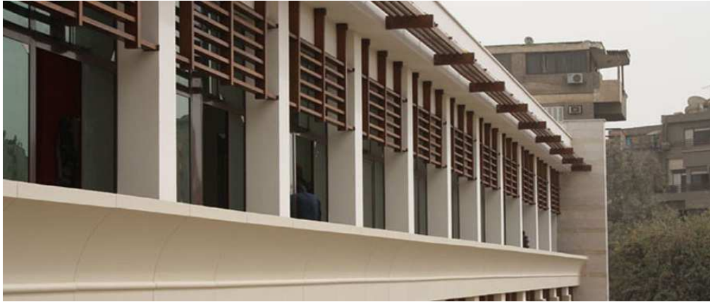
صورة (2-22) توضح استخدام البلكونات الأفقية لمعالجة الواجهة الجنوبية من أشعة الشمس.
