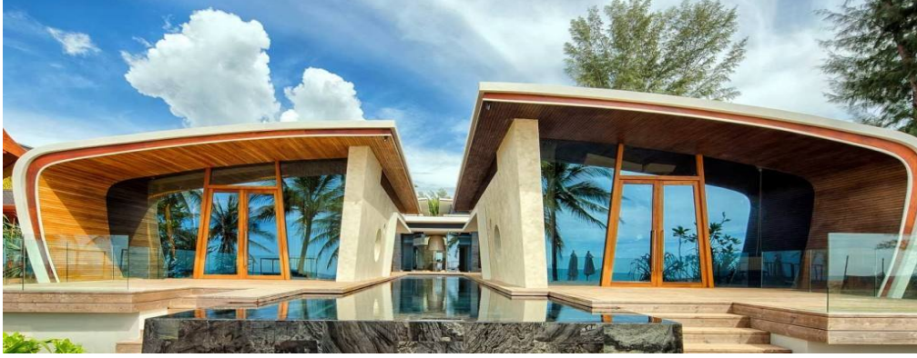
صورة (2-21) توضح استخدام كاسرات الشمس الأفقية الثابتة لمعالجة الواجهة الجنوبية.
