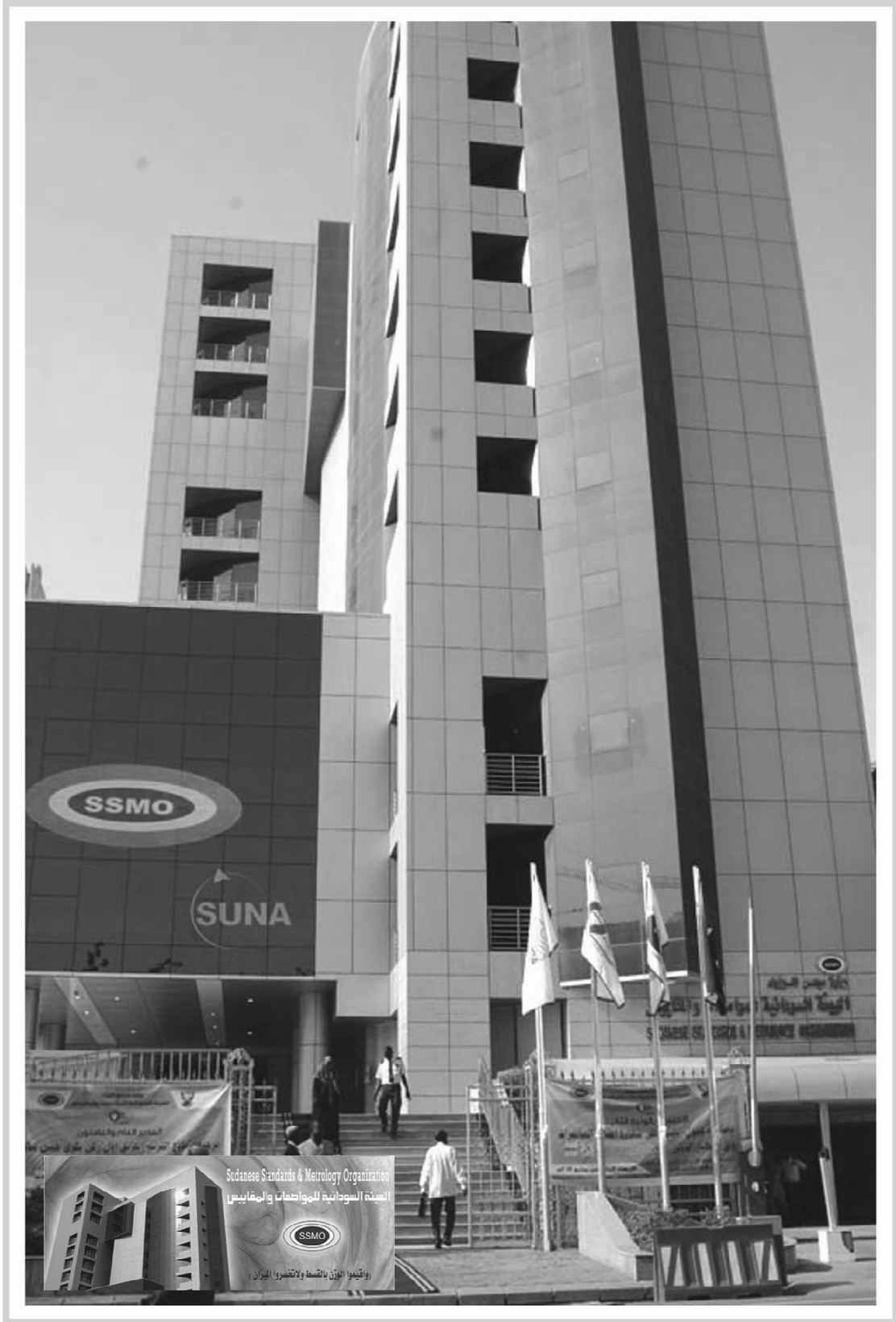
مبنى الهيئة السودانية للمواصفات والمقاييس Sudanese Standards & Metrology Organization
