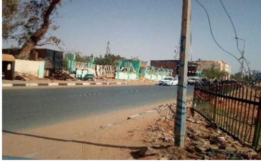
صورة (5-6) السور الخارجي للطابية المصدر: (الباحثة)
