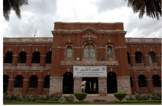
صورة (4-21) مبنى المالية المصدر: (المناطق السياحية، 2019)
