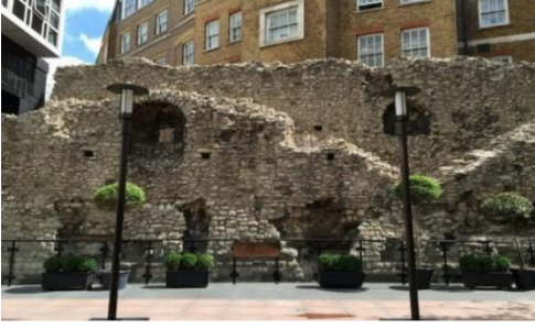
صورة(3-14) أعمدة إضاءة ذات حجم مناسب مع الحائط المصدر: ( historic UK,2019)
