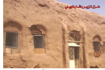
صورة (4-28) قبل الترميم المصدر: (الزبير باشا، 2015)
