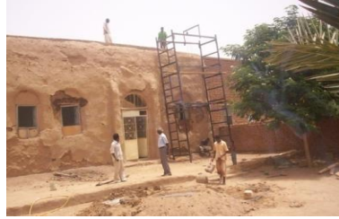
صورة (4-29) أثناء عملية الترميم 2012 المصدر: (الزبير باشا، 2015)
