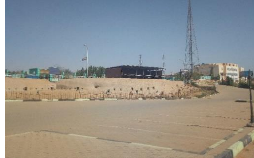
صورة (5-5) توضح عدم وجود سور للحماية المصدر: (الباحثة)
