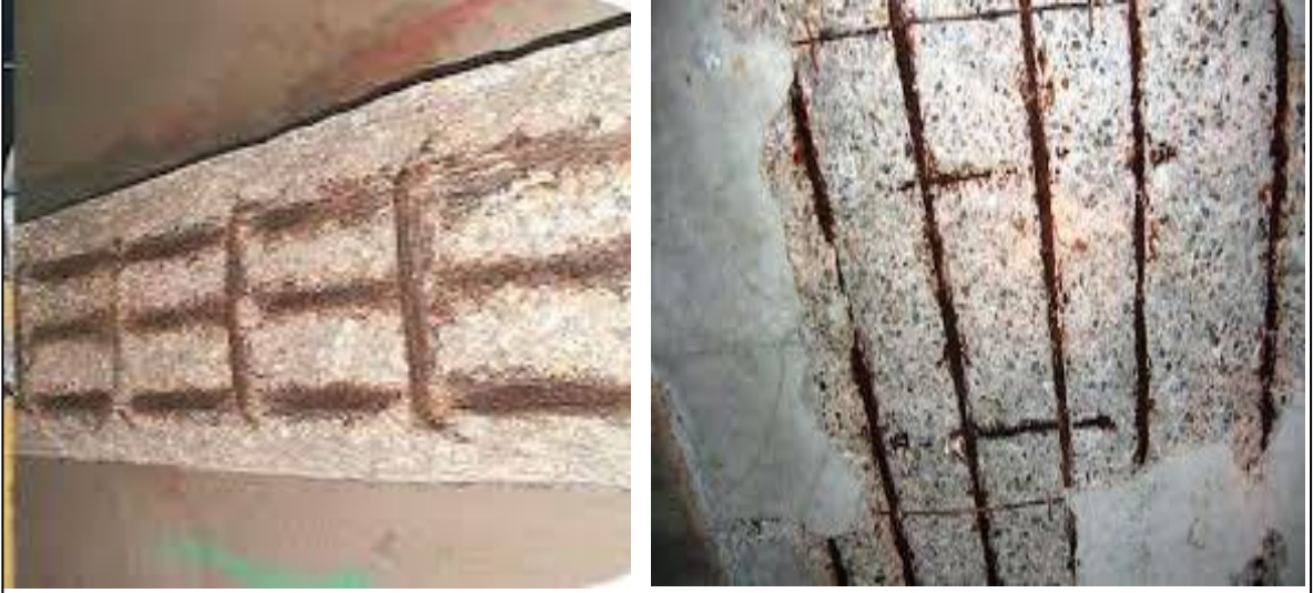
الشكل (3-7) يوضح صدأ حديد التسليح
