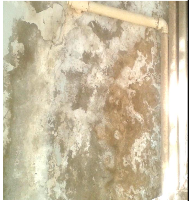
شكل رقم (4-7) يوضح اثر تسرب المياه مجهولة المصدر على حوائط المبنى
