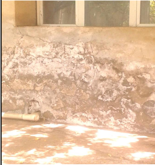
شكل رقم (4-7) يوضح اثر تسرب المياه مجهولة المصدر على حوائط المبنى
