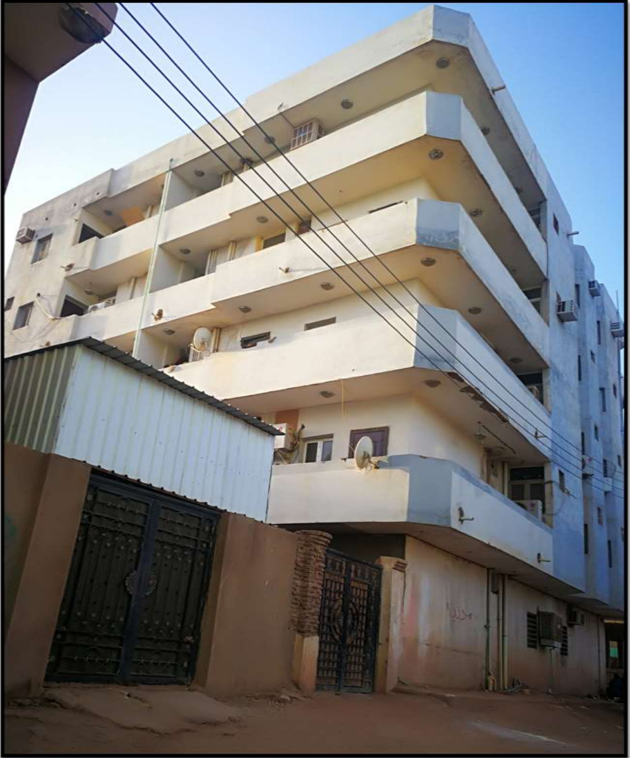
صورة (3-4): الواجهة الجنوبية للنموذج الاول (المصدر: الباحث 2019)
