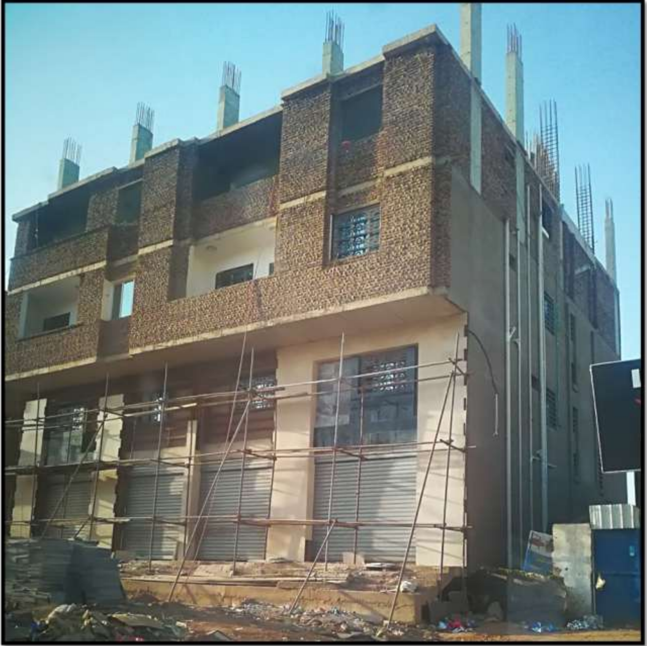
صورة (3-9): الواجهة الشرقية للنموذج الثاني (المصدر: الباحث 2019)
