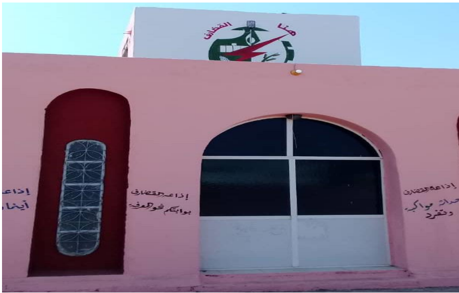
مبنى اذاعة القصارف من الخارج
