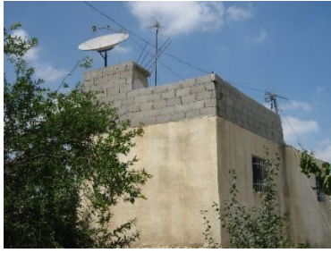
(ج) الواجهة الشرقية
