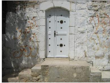
(هـ) المدخل الرئيسي في الواجهة الشرقية
