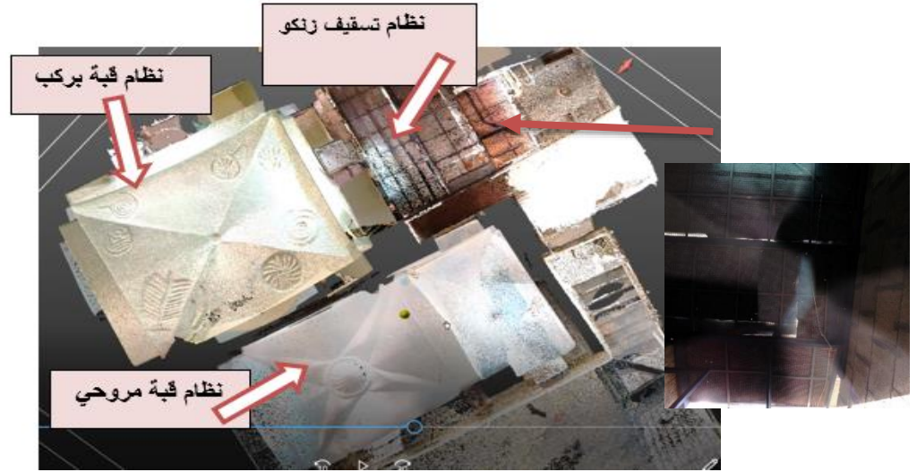
شكل رقم (5-57) يوضح نظام الأسقف المستعملة في مسكن فوزي الرجبي المصدر الباحثة 2020
