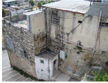
(ب) الواجهة الجنوبية
