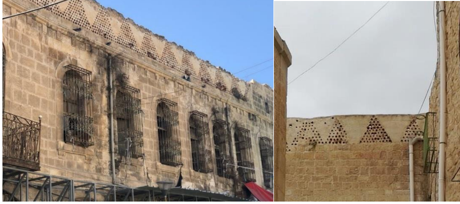
شكل رقم (4-24) (أ) وشكل (4-24) (ب) نماذج من اسوار السطح باستخدام الكيزان ( الفخار ) شارع الشلالة المصدر تصوير الباحثة 2020
