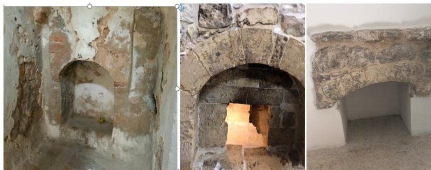
شكل رقم (4-48) يمثل أمثلة متنوعة لأشكال الوجاق في المسكن الخليي المصدر الباحثة 2020
