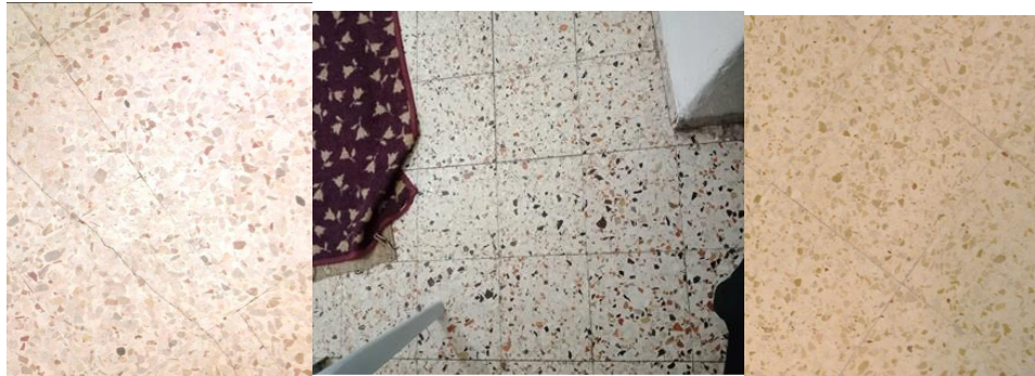
شكل (4-45) نماذج لبلاط بلدي بزرة مأخوذة من مساكن البلدة القديمة المصدر الباحثة 2020
