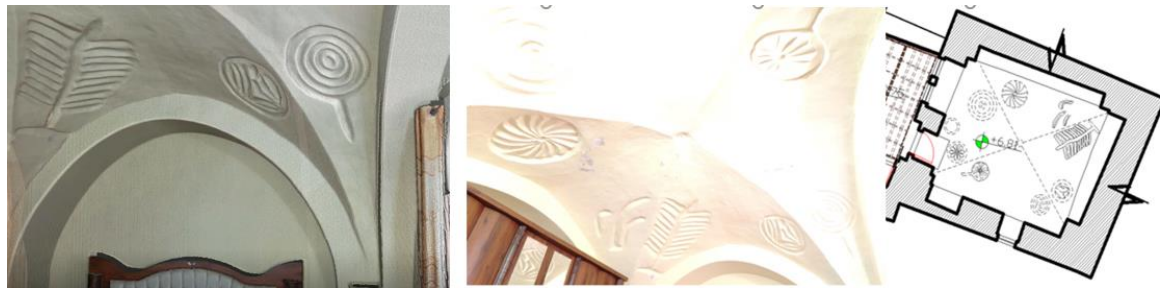
شكل رقم (5-63) نموذج للزخارف الموجودة في سقف غرفة النوم الرئيسية في المستوى الثالث المصدر الباحثة
