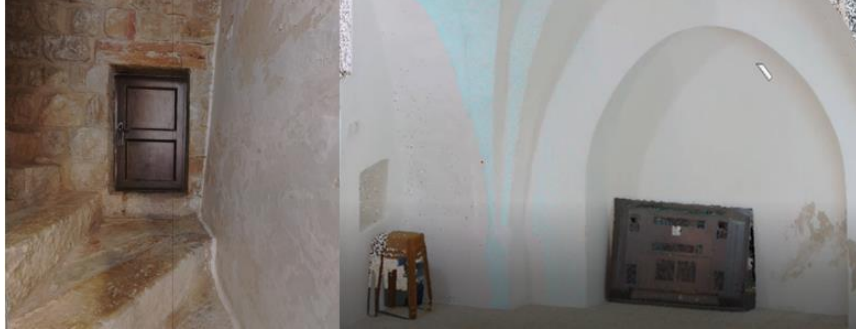
شكل رقم (5-66) يظهر نماذج من الفراغات الخاصة بالخزائن الحائطية مستخدمة في عدد من الأماكن في مسكن فوزي الرجبي كما وجد الوجدان المتعارف تواجده في مساكن البلدة القديمة المصدر الباحثة 2020.
