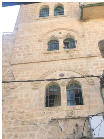
شكل (4-10) يمثل تنوع وغنى في الأشكال والزخارف في الواجهة في البلدة القديمة الخليل المصدر تصوير الباحثة
