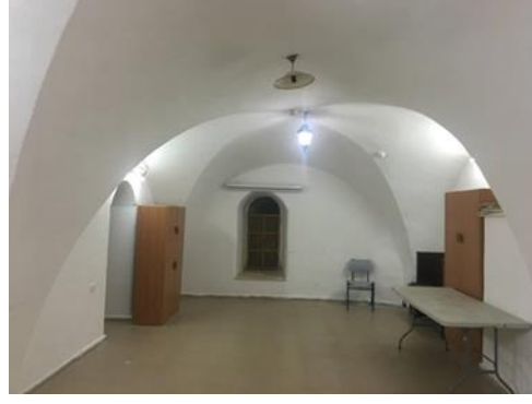
شكل رقم (4-46) سقف القبة متقاطع أو مروحي مع مكان النجفة في السقف المصدر الباحثة 2020
