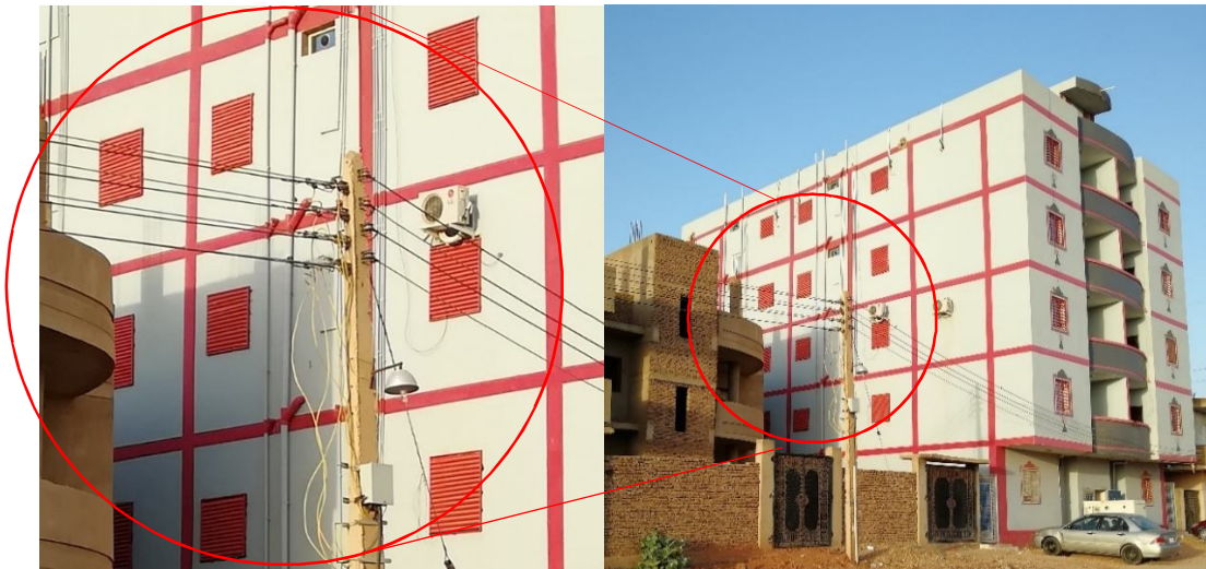
الشكل (48-2-4) يوضح معالجات النوافذ و الشرفات بالشيش لمنع الانكشاف البصري (المصدر: الباحثة)
