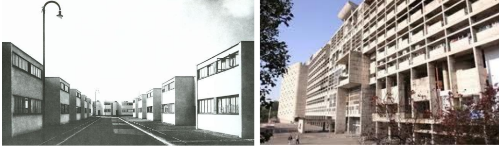
الشكل (2-12) الوحدات السكنية في مرسليليا-فرنسا ، و المساكن المتصلة في ديساو-المانيا ( Classen, H.: Die Weißenhofsiedlung. Beginn eines neuen Bauens, Dortmund, 1990 )
