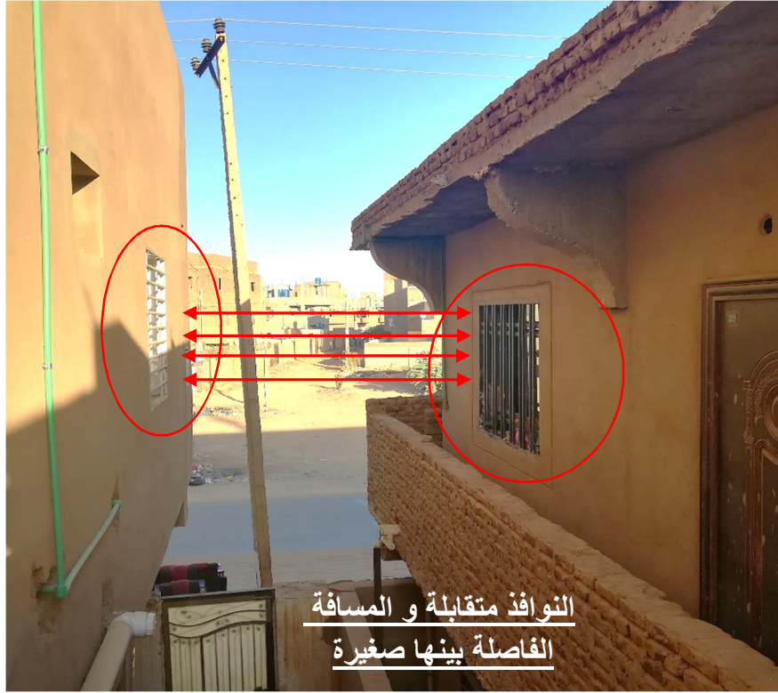
شكل (4-2-11) صورة للنوافذ المقابلة للجار الجنوبي – حالة الدراسة الثانية (المصدر: الباحثة)
