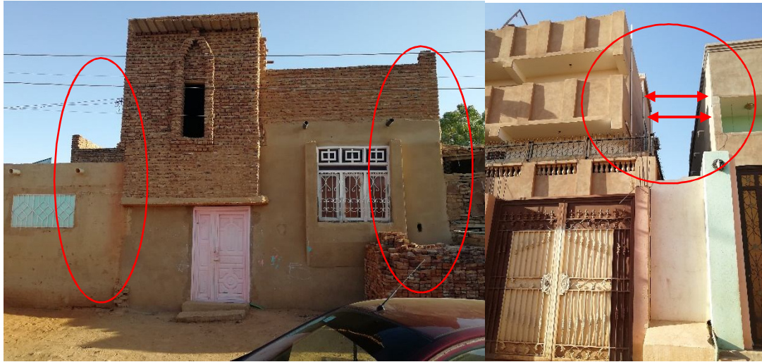
شكل (4-2-61) صور توضح المباني المتلاصقة و ذات الارتداد الصغير (المصدر:الباحثة)
