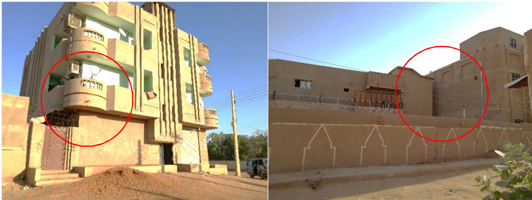
شكل (4-2-62) صور توضح المباني المتلاصقة و ذات الارتداد الصغير (المصدر:الباحثة)
