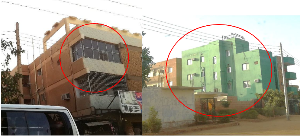
الشكل (47-2-4) يوضح معالجات النوافذ و الشرفات بالزجاج لمنع الانكشاف البصري (المصدر: الباحثة)
