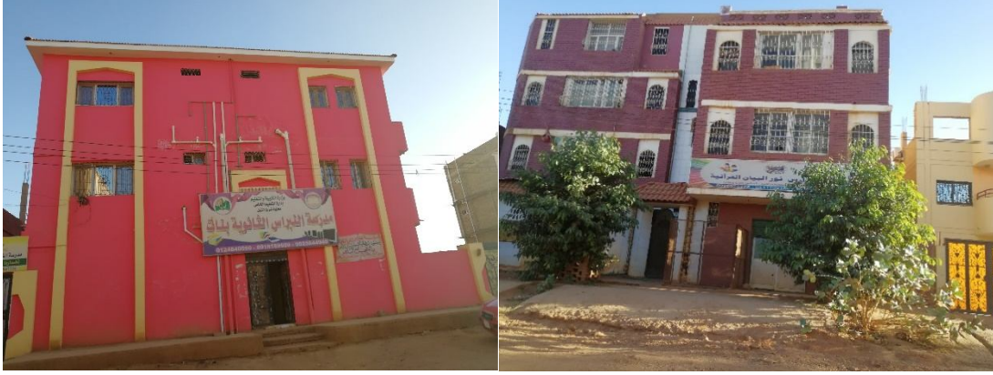
شكل (4-2-60) صور توضح إستخدام المباني السكنية لأغراض تعليمية (المصدر:الباحثة)
