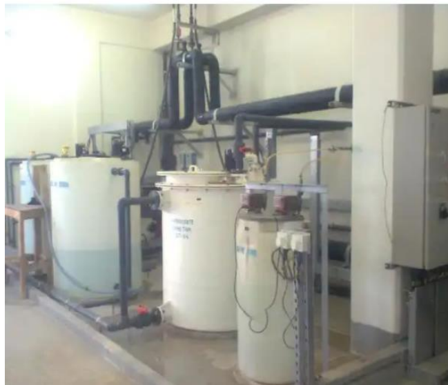
صورة (15-2) توضح مضخات الحقن الكيميائية
