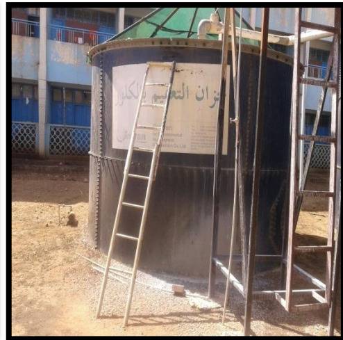
صورة رقم (5-4) : حوض الكلور وخزان محلول الكلور
