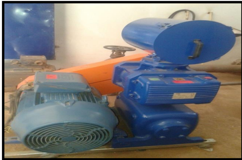
صورة رقم (4-9) : نافخة الهواء (Air Blower)
