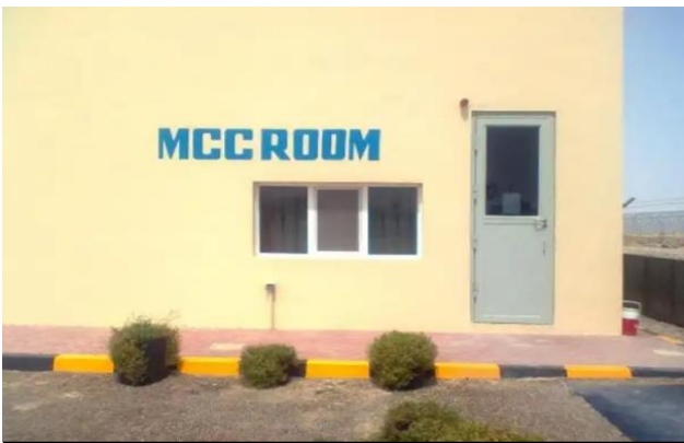
صورة (9-2) توضح غرفة التحكم
