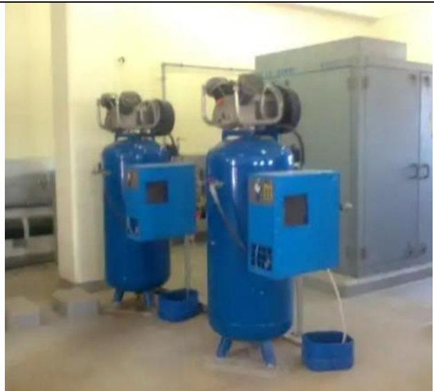
صورة (13-2) توضح نافخات الهواء
