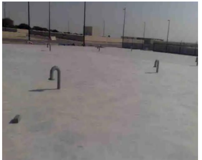
صورة (14-2) توضح حوض تجميع المياه المعالجة
