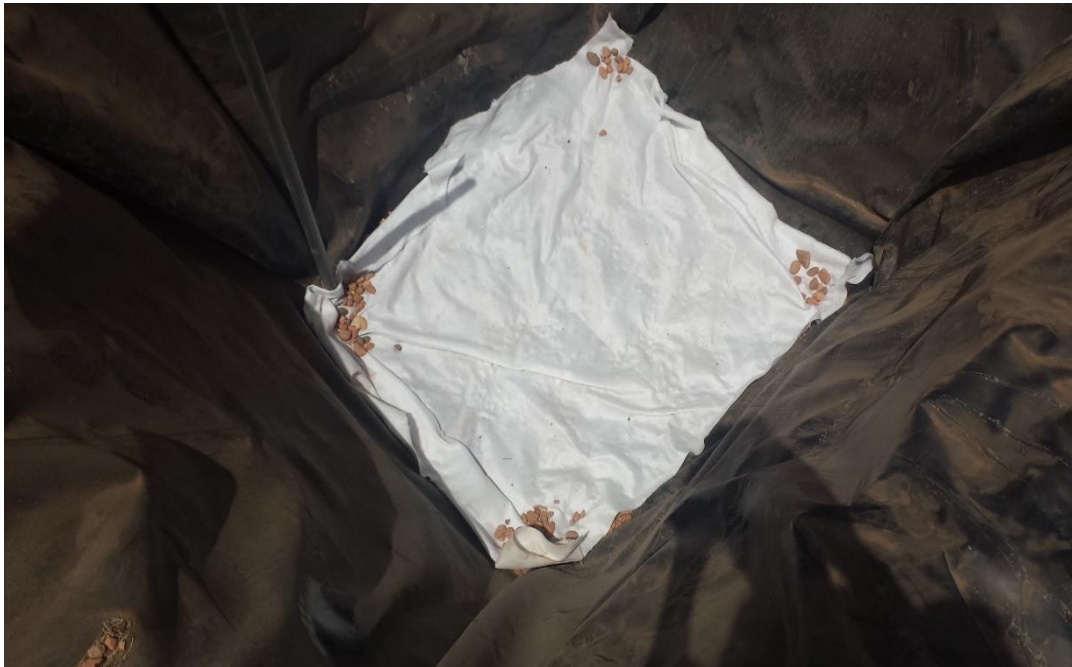
Fig (3.9): Geotextile layer
