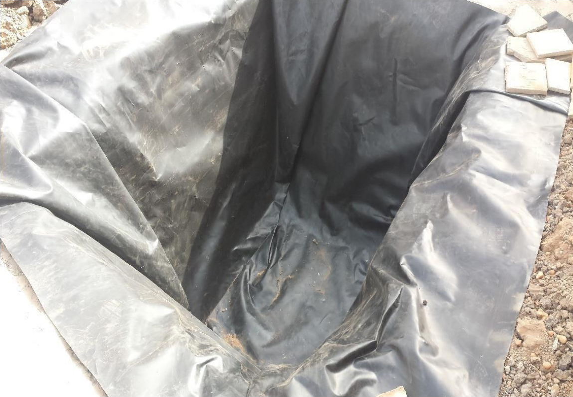
Fig (3.7): setup Geomembranes layer
