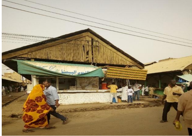
الصورة 4-12 قدم و تهالك المباني بمنطقة الدراسة
