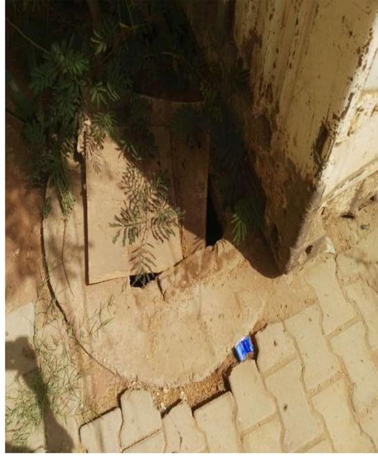
الشكل رقم (3-12): يوضح عدم استخدام الأغطية المناسبة للآبار
