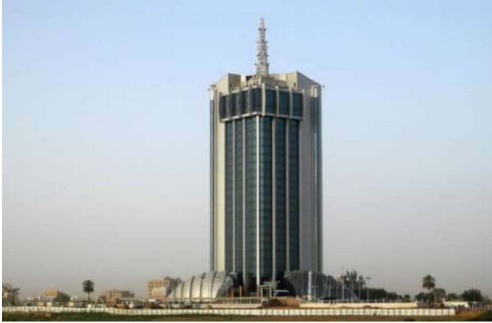
صورة رقم (5-2) توضح الواجهة الشرقية للمبنى المصدر: الباحث، 2017
