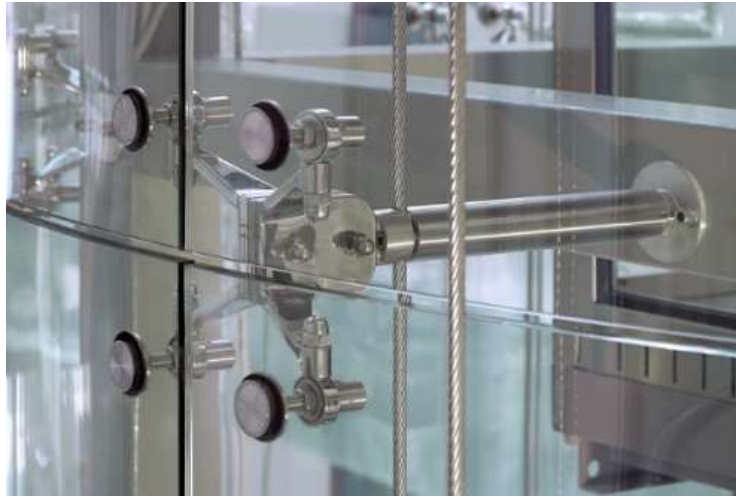
صورة رقم (4-25) توضح نظام التثبيت العنكبوتي
