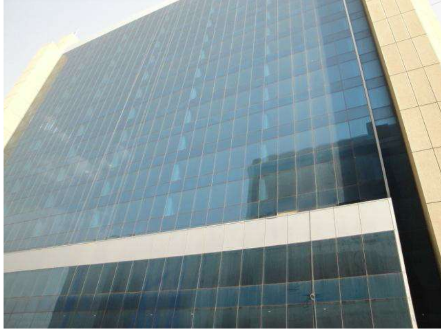
صورة رقم (5-5) توضح الواجهة الشمالية للمبنى المصدر: الباحث، 2017
