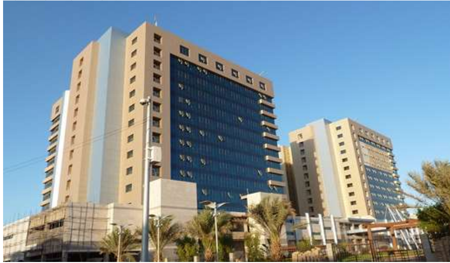
صورة رقم (3-5) توضح الواجهة الجنوبية الغربية للمبنى المصدر: الباحث، 2017
