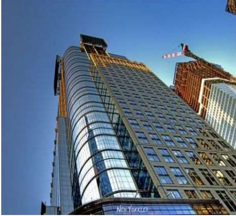
صورة رقم (1-3) توضح مبنى برج كوند ناست
