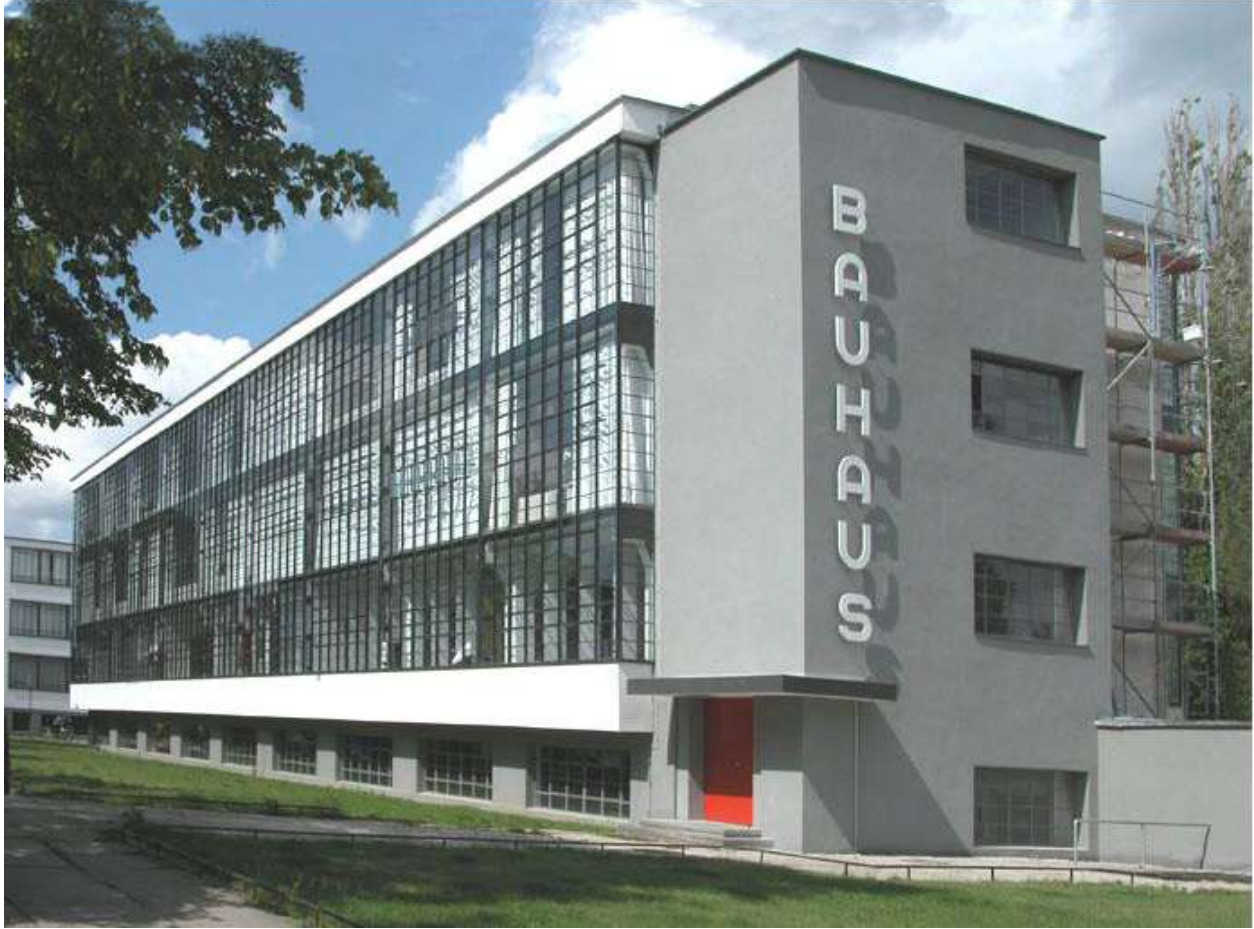
صورة رقم (8-2) مبنى الورش في مدرسة باوهاوس (Bauhaus)
