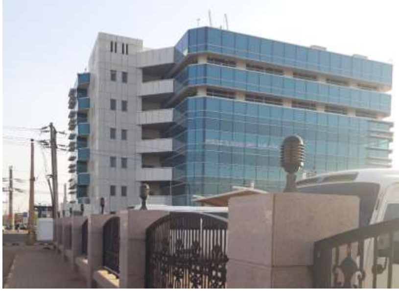
صورة رقم (5-8) توضح الواجهة الشمالية للمبنى المصدر: الباحث، 2017
