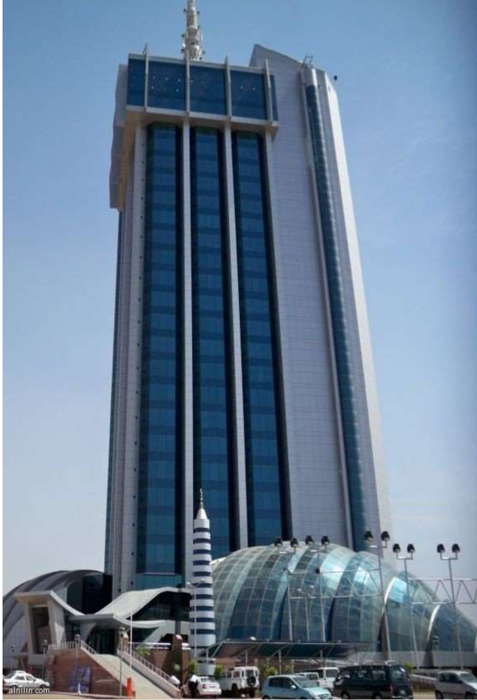
صورة رقم (1-5) توضح الواجهة الشمالية للمبنى المصدر: الباحث، 2017
