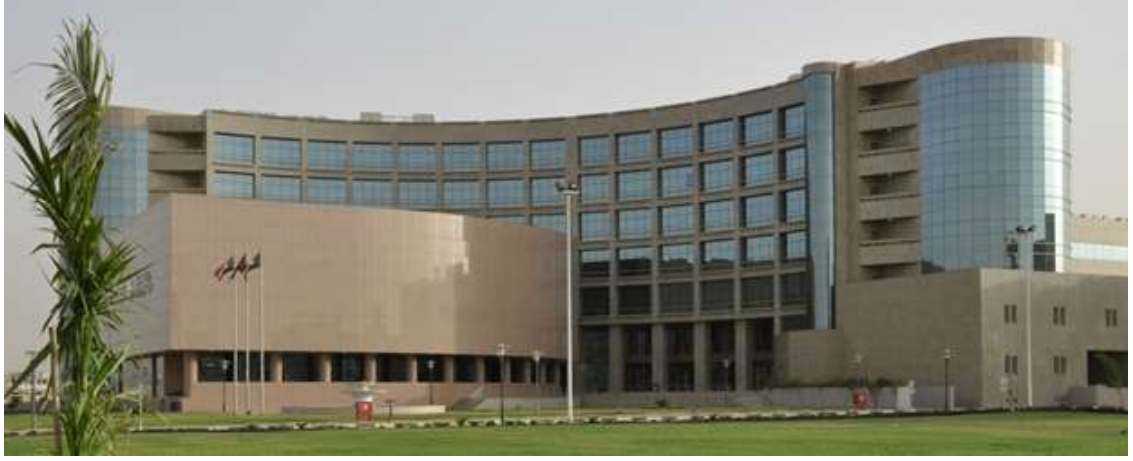
صورة رقم (5-9) توضح الواجهة الشمالية للمبنى المصدر: الباحث، 2017
