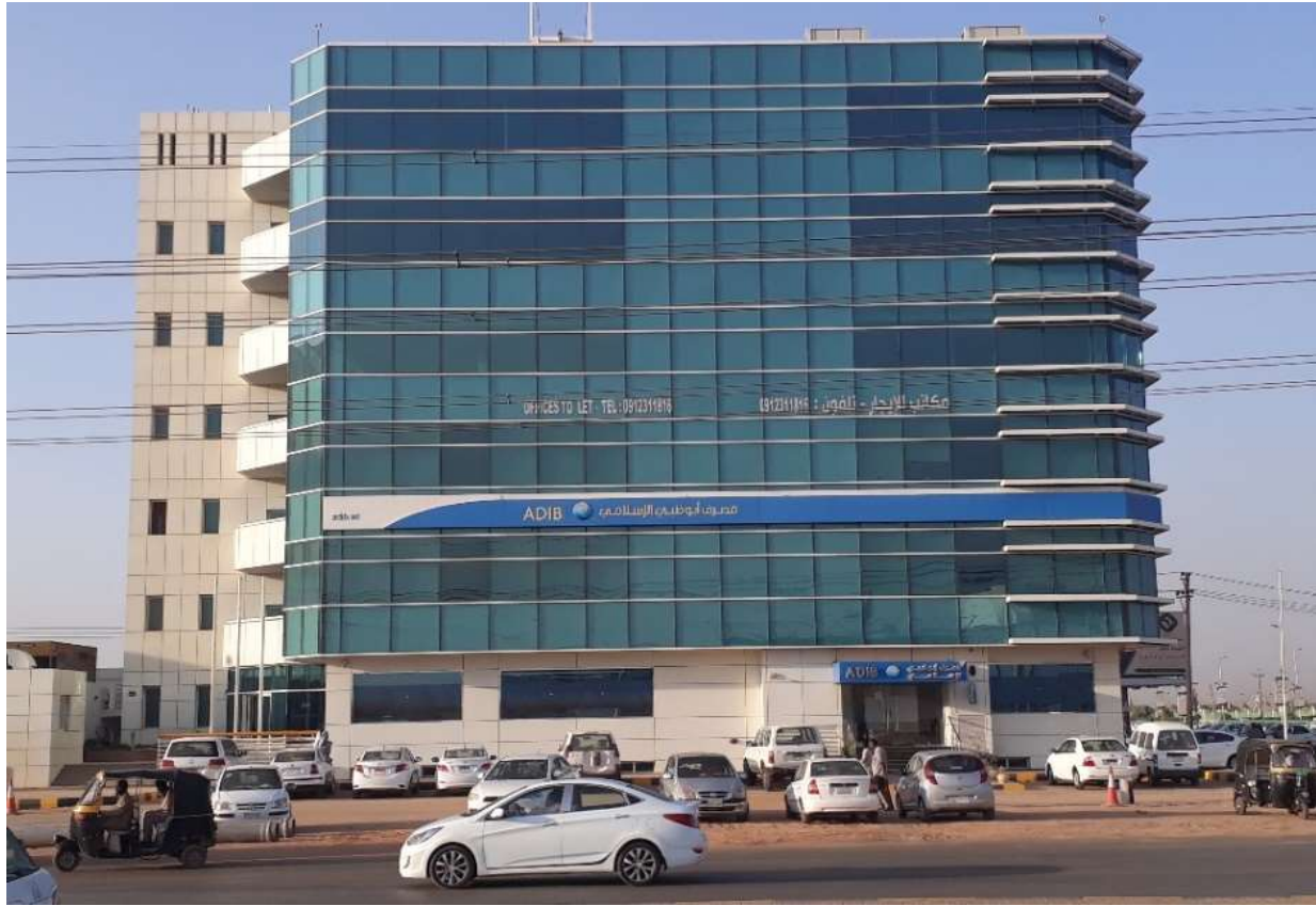
صورة رقم (5-7) توضح الواجهة الجنوبية للمبنى المصدر: الباحث، 2017
