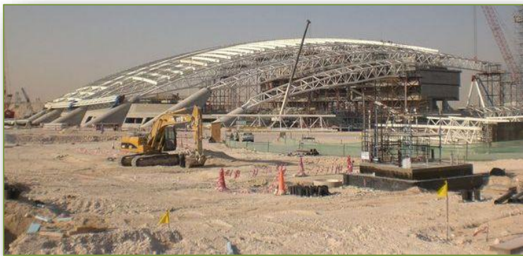
النظام الإنشائي : - Active form 3D truss
