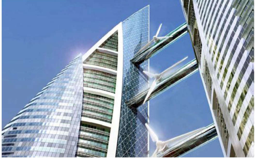
صورة رقم (2-26) يوضح التشكيل بمصادر الطاقة المدمج ( توربينات رياح وخلايا كهروضوئية ) - برج التجارة البحريني المصدر : www.google.com
