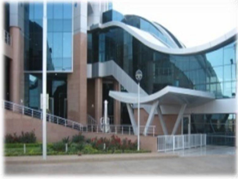
صورة رقم (4-5) توضح التشكيل البيئي بالخلايا الكهروضوئية لبرج الاتصالات – الخرطوم بري المصدر : الباحث
