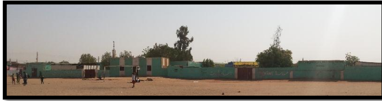
(شكل 5-48) مدرستي البنين والبنات المصدر : الباحث
