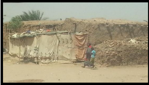
(شكل 5-31) مباني سكنية من الجالوص ( تسمى ظهر التور ) المصدر : الباحث
