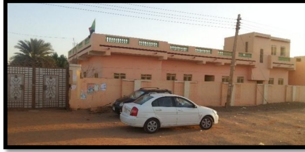
(شكل 5-18) مبنى حكومي - الوحدة الإدارية المصدر : الباحث
