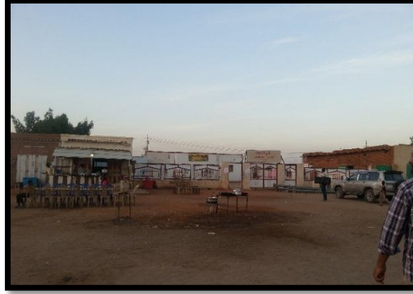
(شكل 5-29) نادي الشباب بمركز المربع المصدر : الباحث
