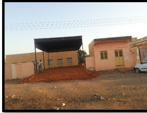
(شكل 5-19) مبنى الدفاع المدني المصدر : الباحث
