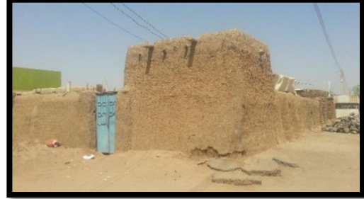
(شكل 5-31) مباني سكنية من الجالوص ( تسمى ظهر التور ) المصدر : الباحث
