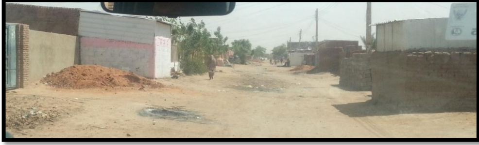
(شكل 5-34) شارع بعرض 15م المصدر : الباحث
