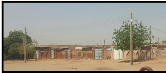
(شكل 5-11) مباني سكنية من الطوب الأحمر المصدر : الباحث
