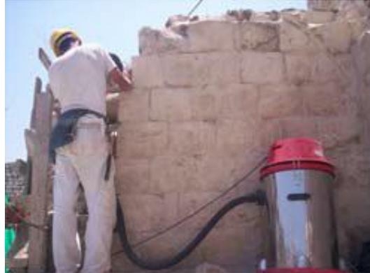
صورتوضح: نفخ الهواء المضغوط داخل الفراغ
