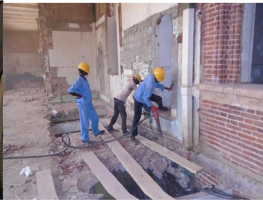
الشكل (4-34) عملية ازالة الاسقف الخرسانية الشكل (4-35) السقف بعد ازالة الخرسانة
