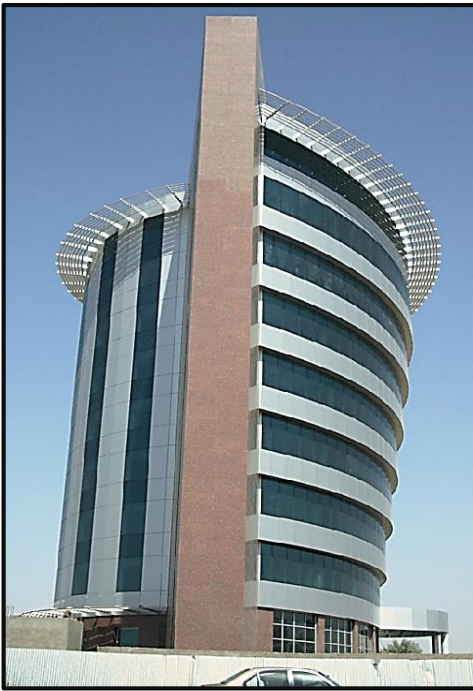
شكل ( ١٢ - ٤ ) يوضح كاسرات الشمس الأفقية في أعلى مبنى شركة هجليج المصدر : www.murtadamaaz.sd
