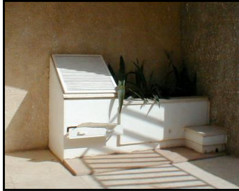
شكل (٣-٢٥) يوضح استخدام الملقف بالمبنى المصدر: د. عثمان الخير
