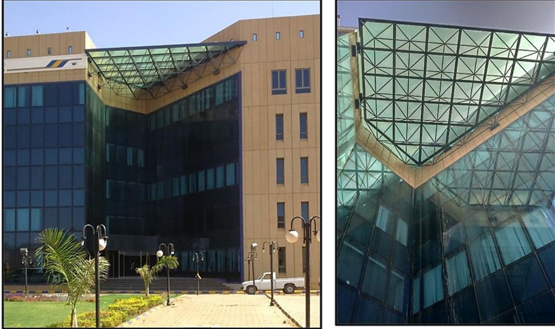
شكل ( ١٧ - ٤ ) يوضح المداخل الرئيسية لمبنى إدارة الخطوط الجوية السودانية
