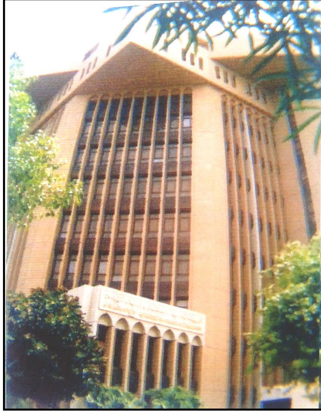
شكل (٣-٩) يوضح نموذج لاستخدام كاسرات الشمس الرأسية
