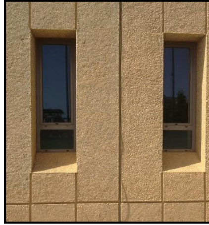
شكل ( ٤ - ١٩) يوضح توقيت النوافذ ضمن سمك الحائط للحماية من أشعة الشمس المباشرة
