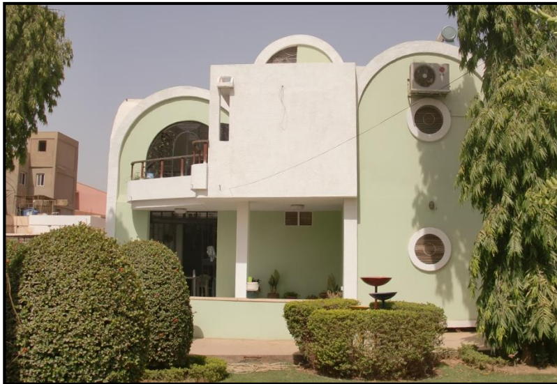
شكل (٣-٢٧) يوضح تشكيل السقف لتقليل الكسب الحراري المصدر: د. عثمان الخير
