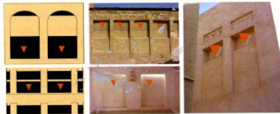
شكل (3-5) ملاقف الهواء (حركة الهواء)
