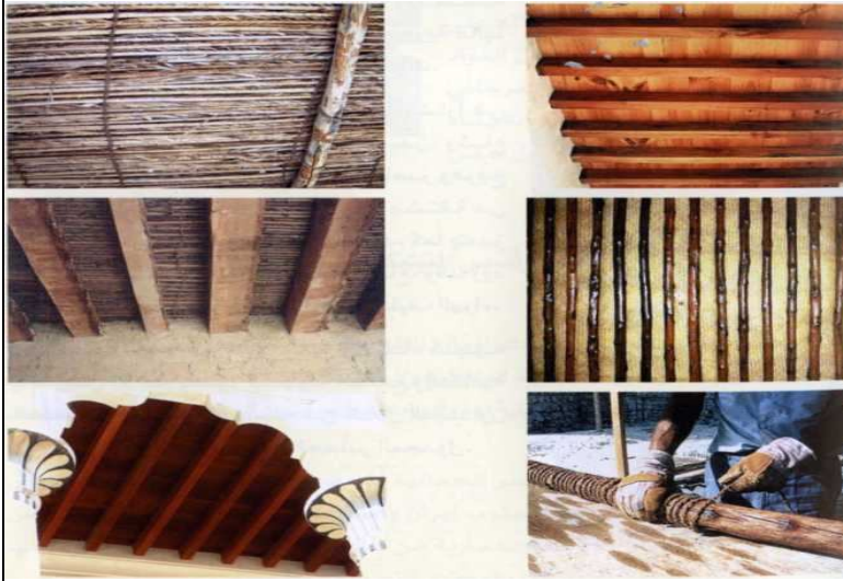
شكل (48) استخدام الأخشاب في تسقيف العمائر التقليدية
