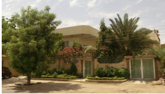
الصورة (5-27) الواجهة الجنوبية للحالة الدراسية السادسة- الخرطوم بحري.- المصدر : الباحث
