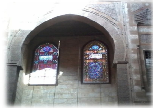
الشكل رقم (4-21) صورة توضح: استخدام القمرية في -مسجد الغوري- القاهرة المصدر (الباحث)
