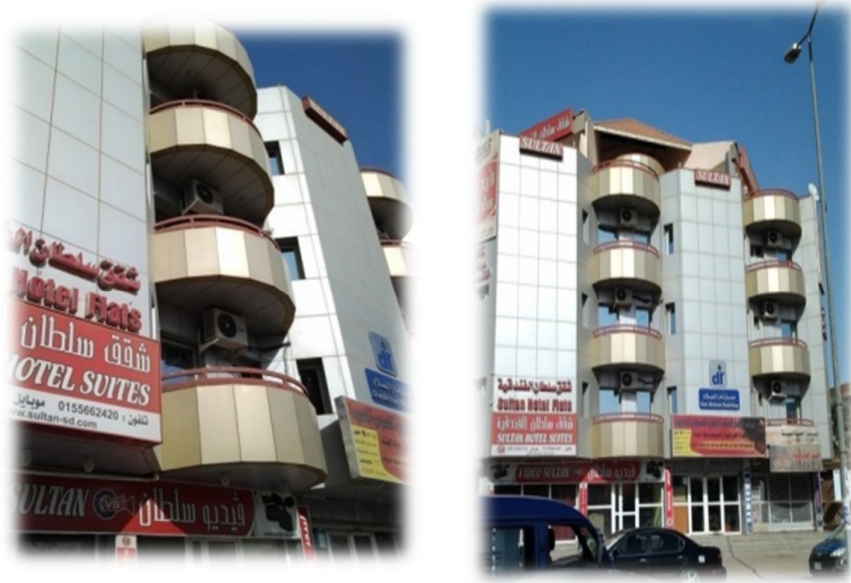
الشكل (5-6) صورة توضح: إستخدام تجليد ألومنيوم شديد اللمعان المصدر(الباحث)
