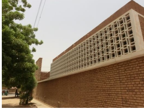
الشكل (5-23) صورة توضح واجهة شمالية للحالة الخامسة -أمدرمان- المصدر : الباحث
