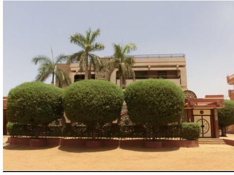
الشكل (5-21) صورة توضح الواجهة الشمالية للحالة الدراسية الرابعة -أمدرمان - المصدر : الباحث
