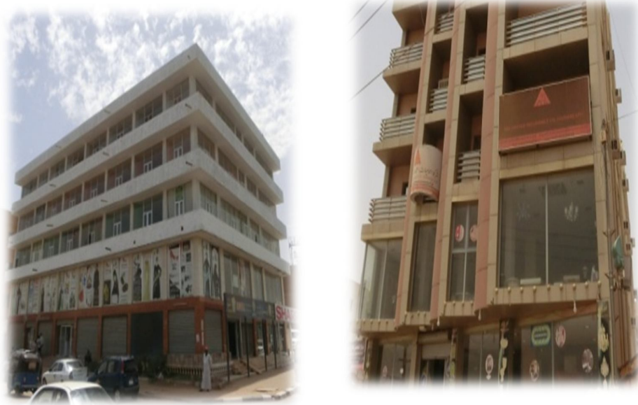
الشكل (5-7) (5-8): صور توضح أستخدام زجاج غير معالج حراريا" لمصدر(الباحث)
