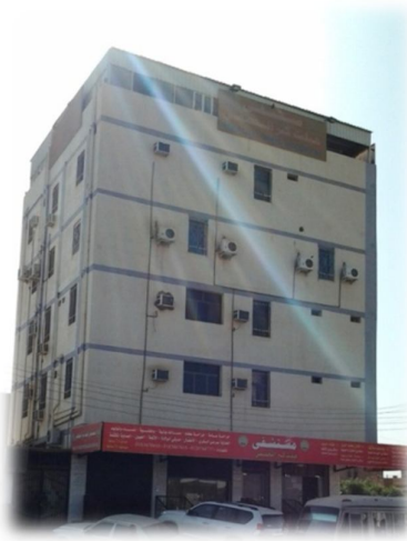
الشكل (11-5): صورة توضح عدم استخدام أساليب تصميمية علي الواجهات تلائم المناخ المصدر(الباحث)
