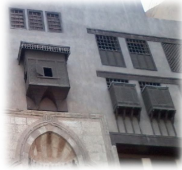
الشكل (4-8): صورة توضح إستخدام المشربية-القاهرة المصدر: (الباحث)
