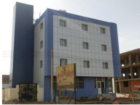
الشكل (5-12) صورة الواجهة الشرقية للحالة لدراسية الأولى- الخرطوم بحري- المصدر : الباحث
