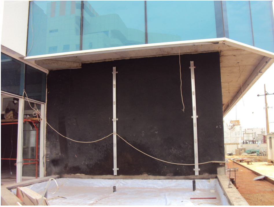
شكل رقم(3-23) يوضح عمل عازل للماء والرطوبة قبل تركيب الواح الحشوة.
