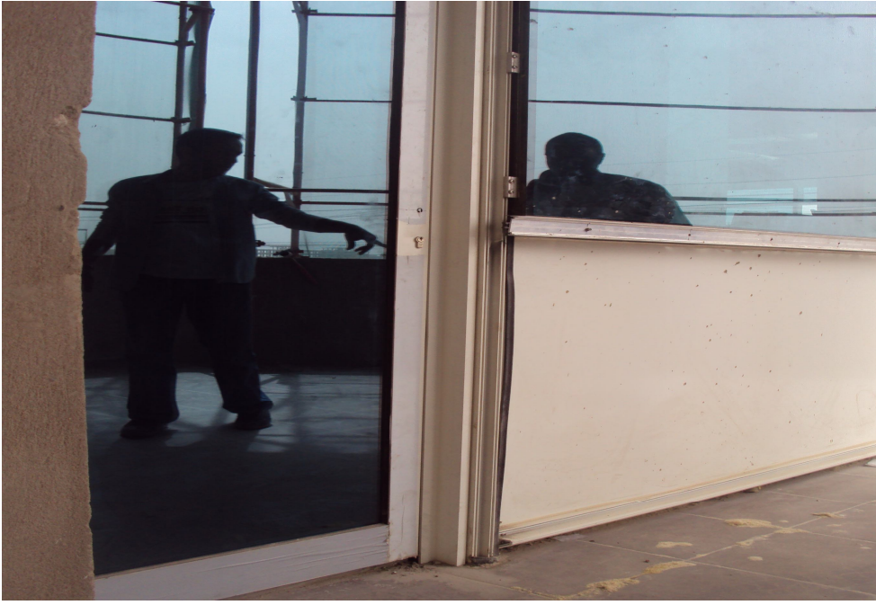
شكل رقم (21-3) يوضح عمل عازل الحريق في كل طابق في حائط ارتفاعه متر
