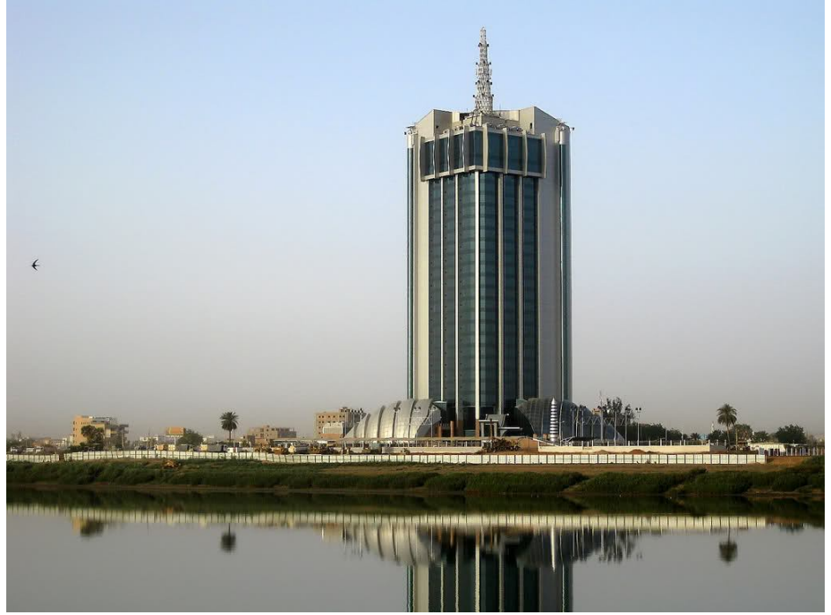
شكل رقم(3-6) يوضح واجهة المبنى من الجهة الشمالية.
