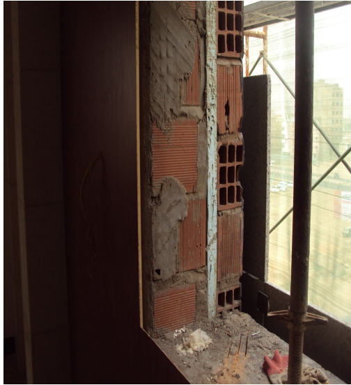
شكل رقم (3-28) يوضح عمل العازل الحراري في الحائط
