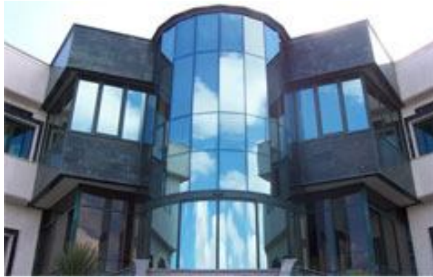
شكل رقم(2-4) يوضح الزجاج المزدوج العازل.
