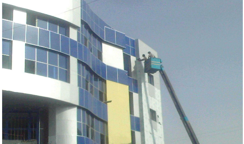
شكل رقم(2-14) يوضح الخطوة الثالثة لتركيب الواح الحشوة
