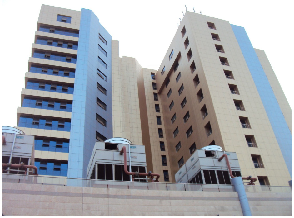
شكل رقم(3-13) يوضح وضع ماكينات التكييف المركزي في المبنى
