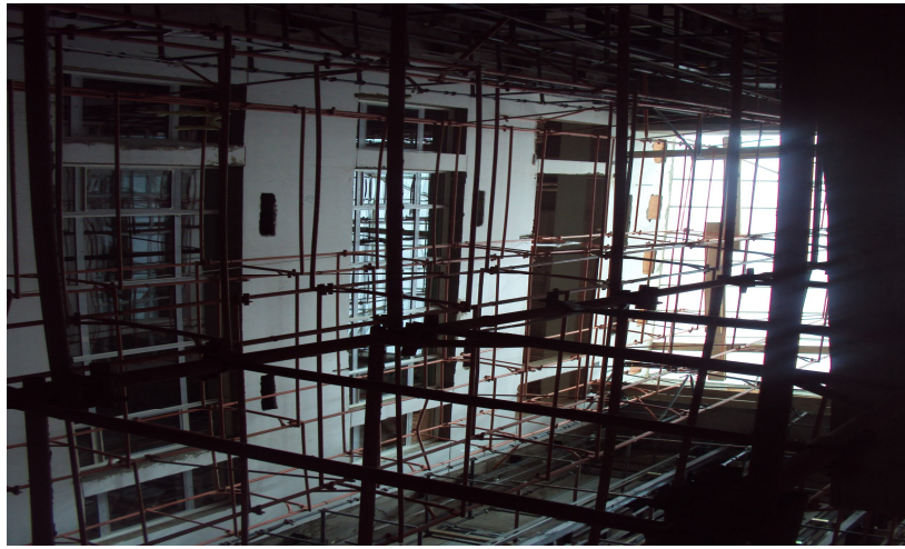
شكل رقم (3-29) يوضح السقالة المستخدمة في تركيب الرخام والجرانيت
