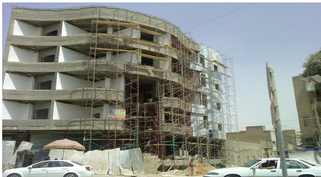
شكل رقم (12-2) يوضح الخطوة الاولى لتركيب الواح الحشوة مبنى بمدينة بغداد.
