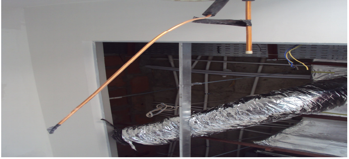
شكل رقم (30-3) يوضح انابيب التكييف المركزي وبالخارج كسوة الحائط بالجرانيت
