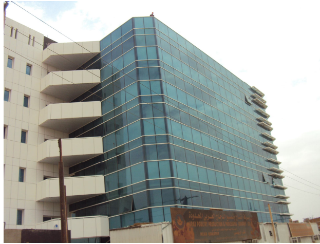
شكل رقم(3-24) يوضح واجهة للمبنى استخدم في تكسيتهما الواجهات الزجاجية والواح الحشوة
