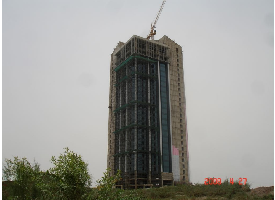
شكل رقم (3-3) يوضح المبنى قبل اكمال العمل.
