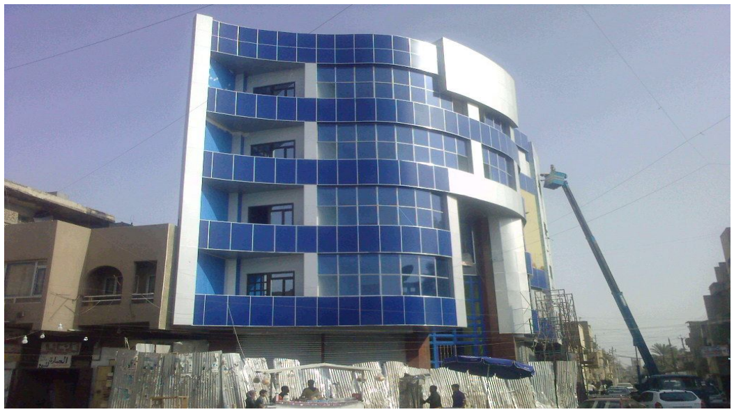
شكل رقم(2-15) يوضح منظر المبنى بعد اكمال تركيب الواح الحشوة
