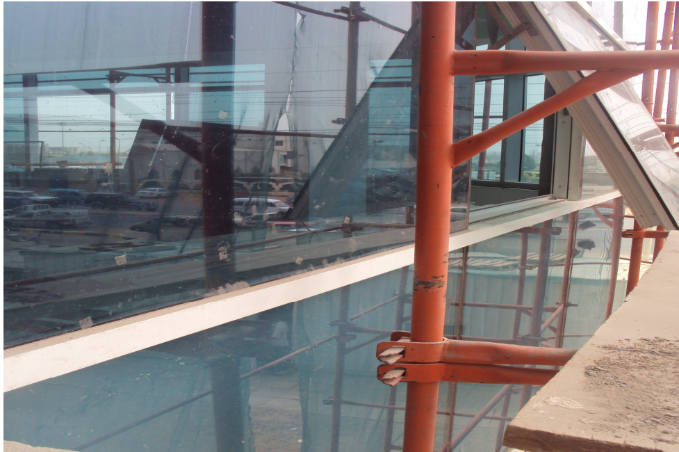
شكل رقم (20-3) يوضح وضع السقالة الثابتة لتركيب الواجهات الزجاجية في المبنى
