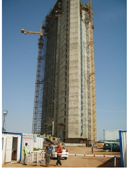
شكل رقم (1-3) يوضح المبنى قبل تكبسيته.
