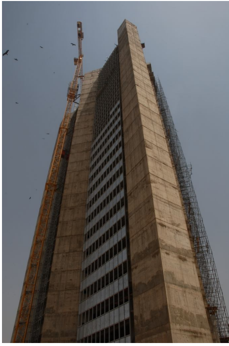
شكل رقم (2-3) يوضح المبنى اثناء التكبسية.
