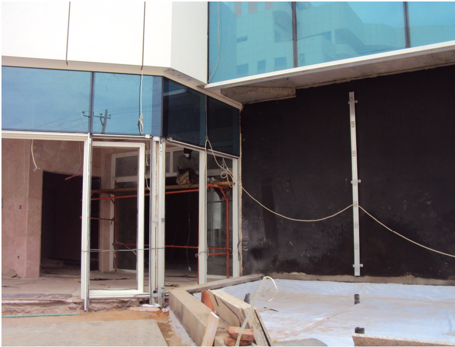
شكل رقم (22-3) يوضح عمل عازل للماء والرطوبة قبل تركيب الواح الحشوة.
