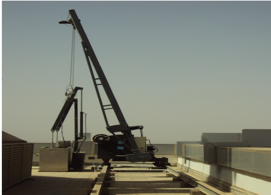
شكل رقم(3-10) يوضح وضع السقالة في صيانة ونظافة الواجهات الزجاجية والواح الحشوة في المبنى.
