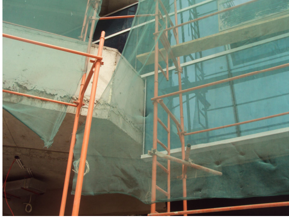
شكل رقم (19-3) يوضح تكسية الطائر بالواح الحشوة
