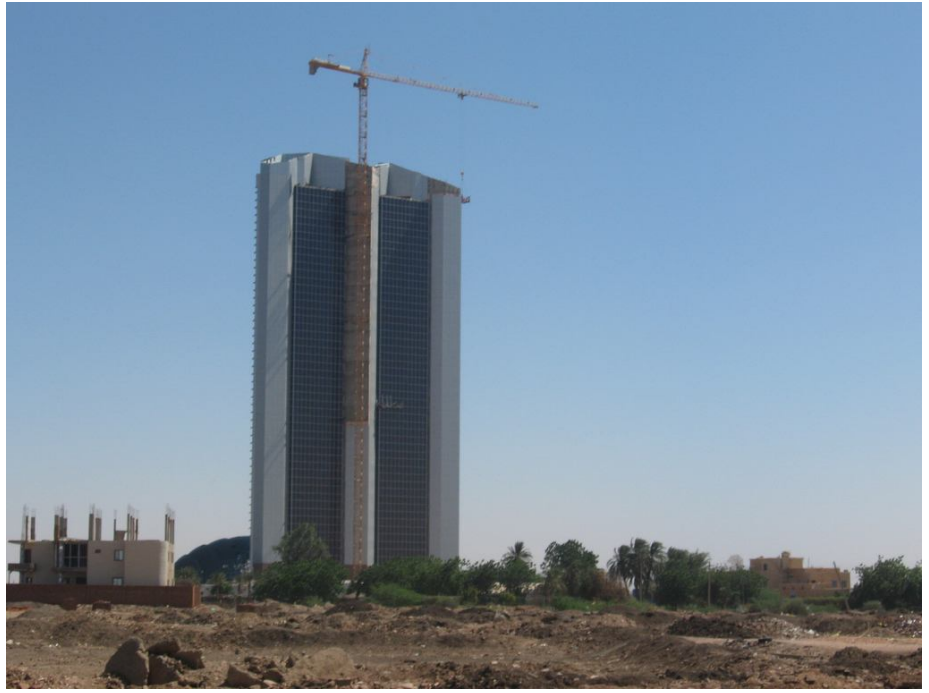
شكل رقم (3-4) يوضح الواجهة الجنوبية توضح الزجاج المستخدم لانتاج الطاقة الكهربائية.
