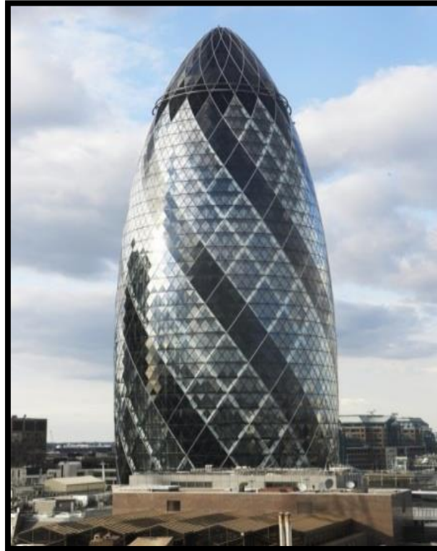
شكل (3-14) مبنى سويس ري في لندن
