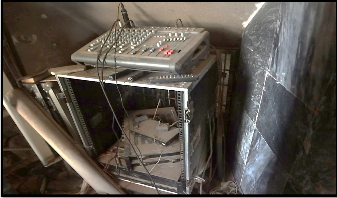
شكل 4-9 : غرفة الصوتيات بمسجد جامعة الخرطوم
